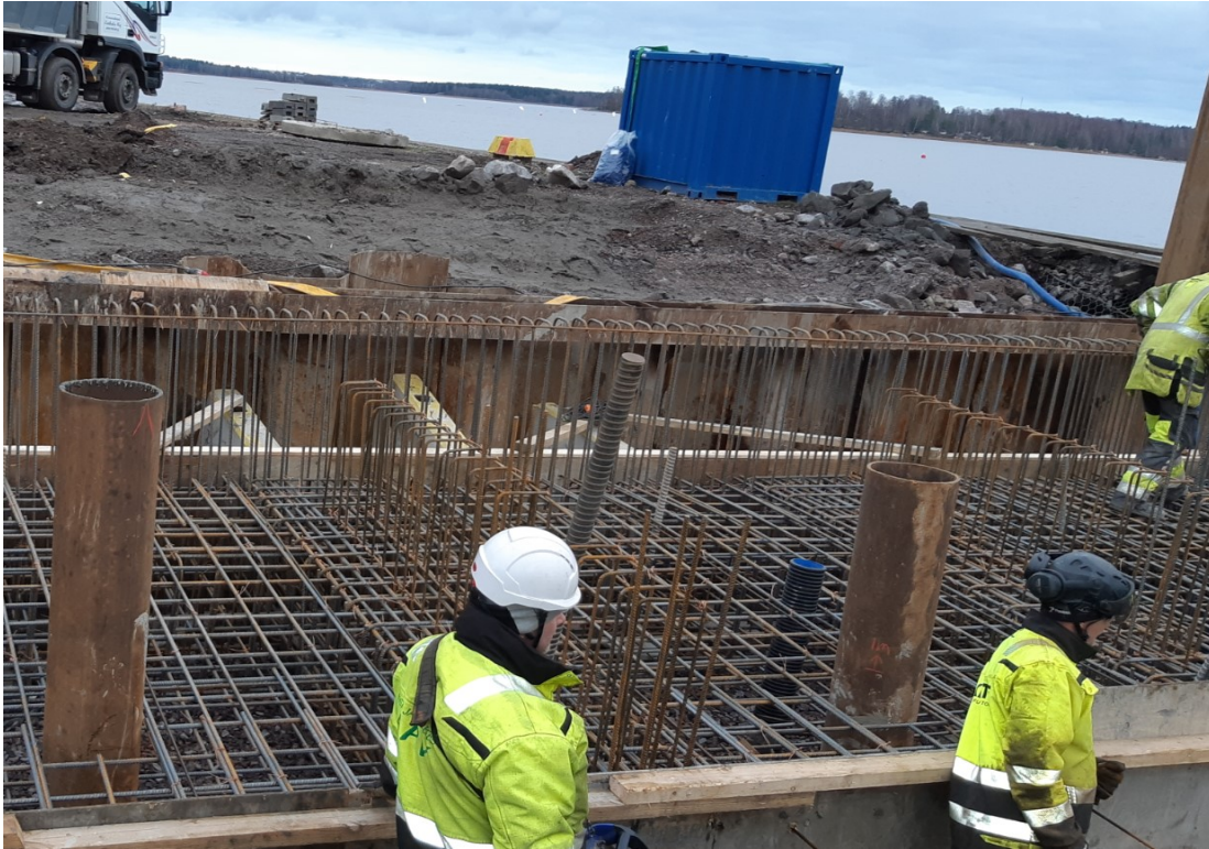
Kuva 18: Kanavamuurin pohjalaatan raudoitus- ja muottitöitä
