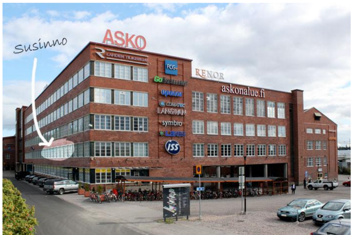
Kuva 5. Askon alueen toimistorakennus, Lahti.
