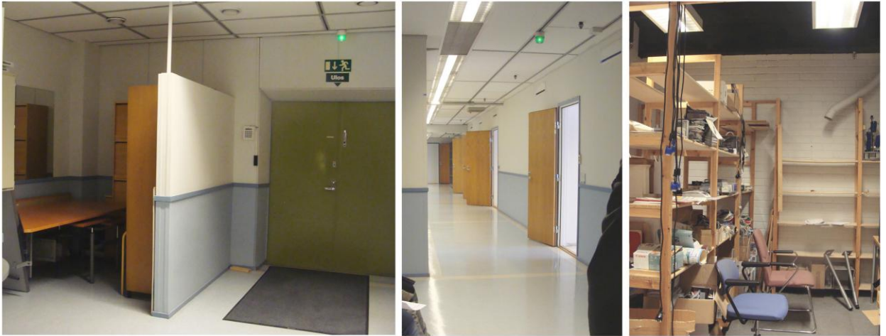
tilat ennen remonttia
