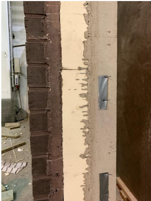
Bild 4. Sandwichelement med tegelfasad
