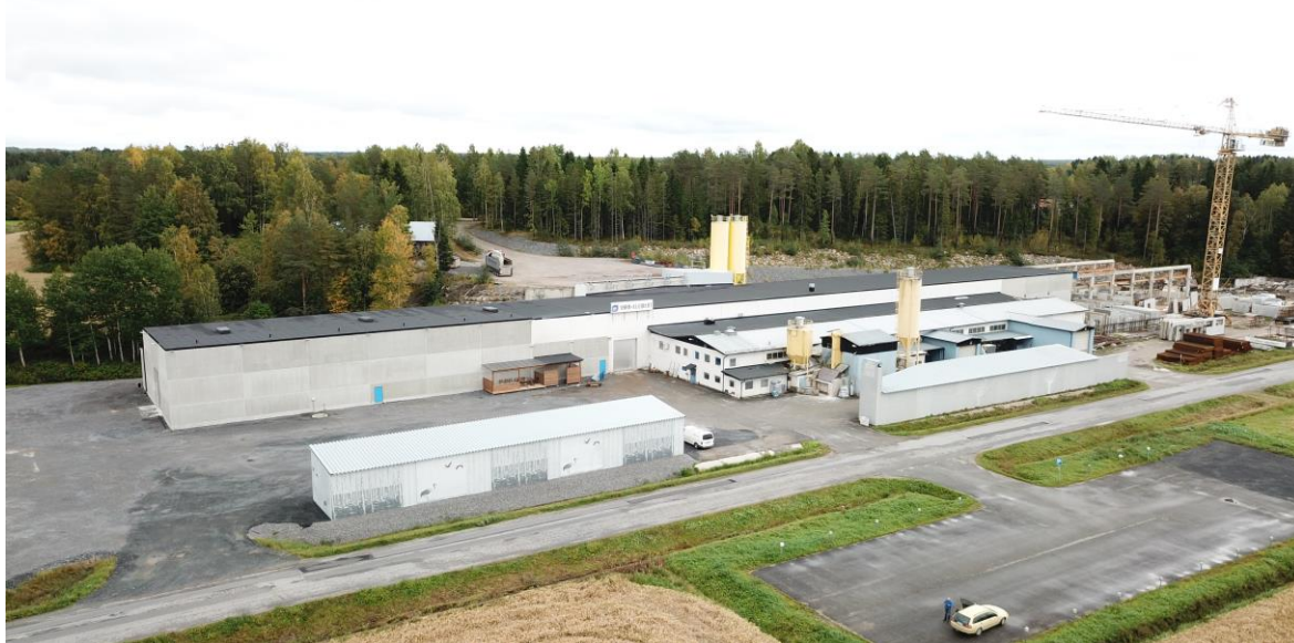
Bild 1. Tara Elements Fabrik, Nedervetil, efter expanderingsbygget år 2017.
