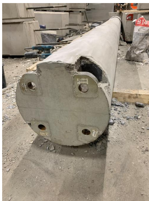
Bild 3. Rundpelare i lager
