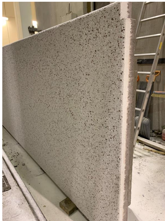
Bild 5. Vittvättbetong fasad på skalelement
