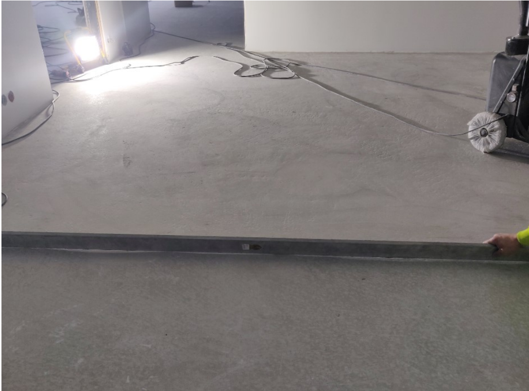
KUVA 1. Lattian tasaisuuden varmistaminen mittalaudalla (kuva YIT:n työmaalta 2020)
