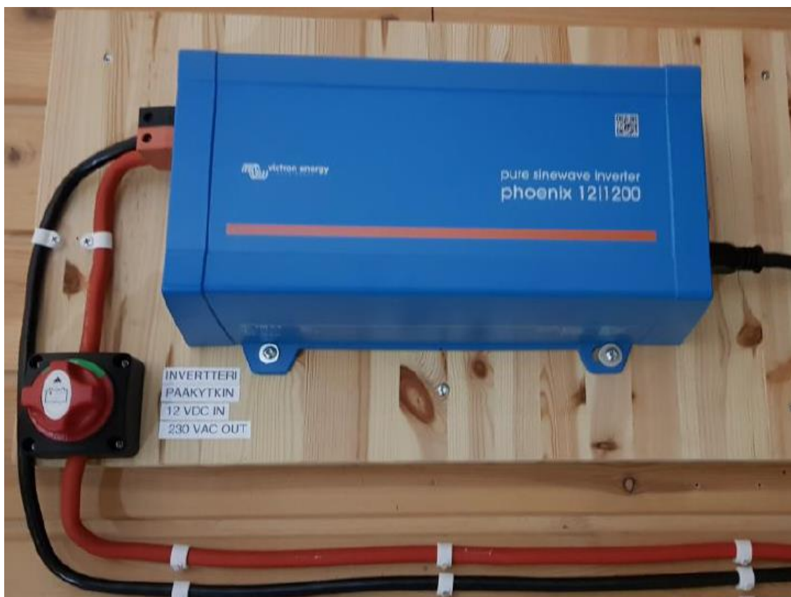
Kuva 43. Inverteri asennettuna.
