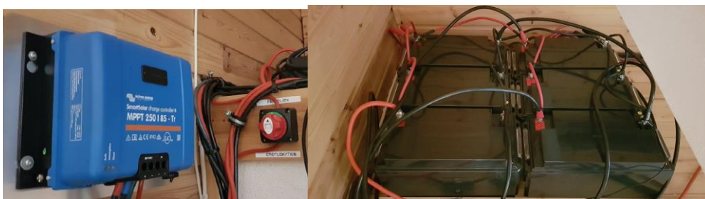
Kuva 41. 12V:n lataussäätimen ja akuston kytkentä.
