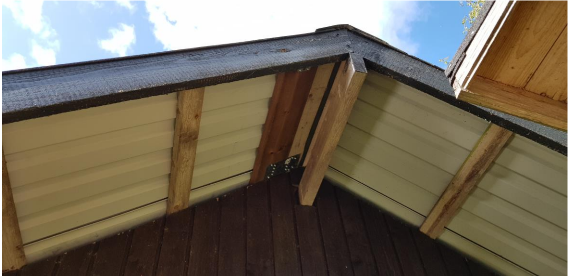
Kuva 28. Peltikaton tukirakenteita.
