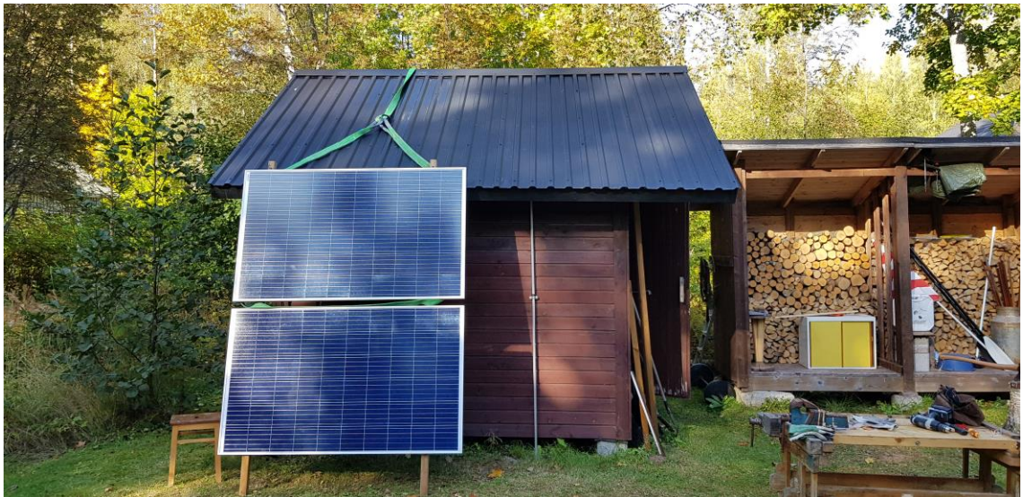
Kuva 33. Aurinkopaneelien nostovalmistelu vajan katolle.
