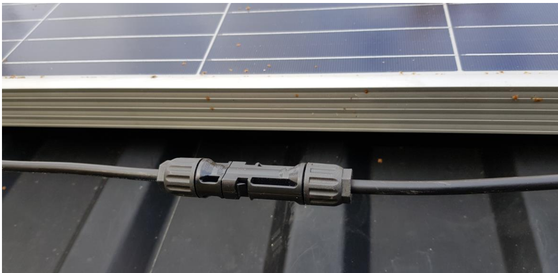
Kuva 36. Aurinkopaneelien johdotusta kytkettynä.
