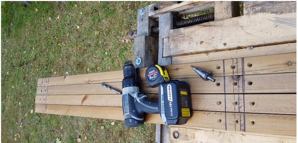
Kuva 31. Aurinkopaneelien tukipuurakenteita asennusreikineen.
