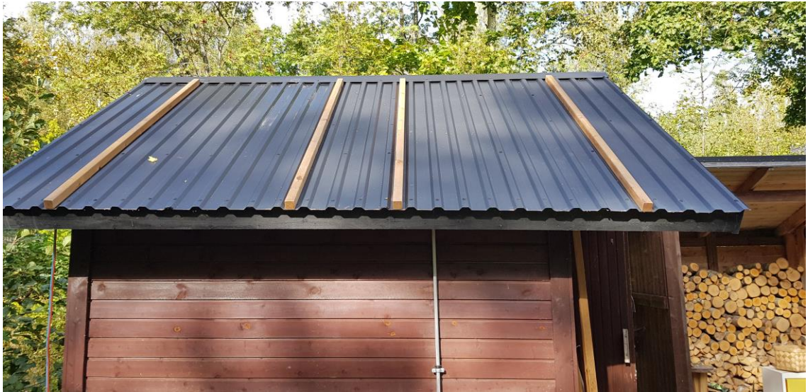
Kuva 29. Aurinkopaneelien tukipuurakenteiden mitoitus.
