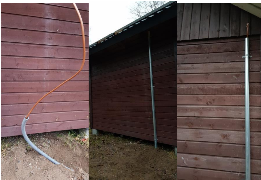
Kuva 38. Aurinkopaneelikaapelin maahan asennus ja suojaus.
