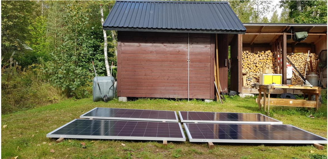
Kuva 32. Aurinkopaneelit kiinnitetty tukipuurakenteeseen.
