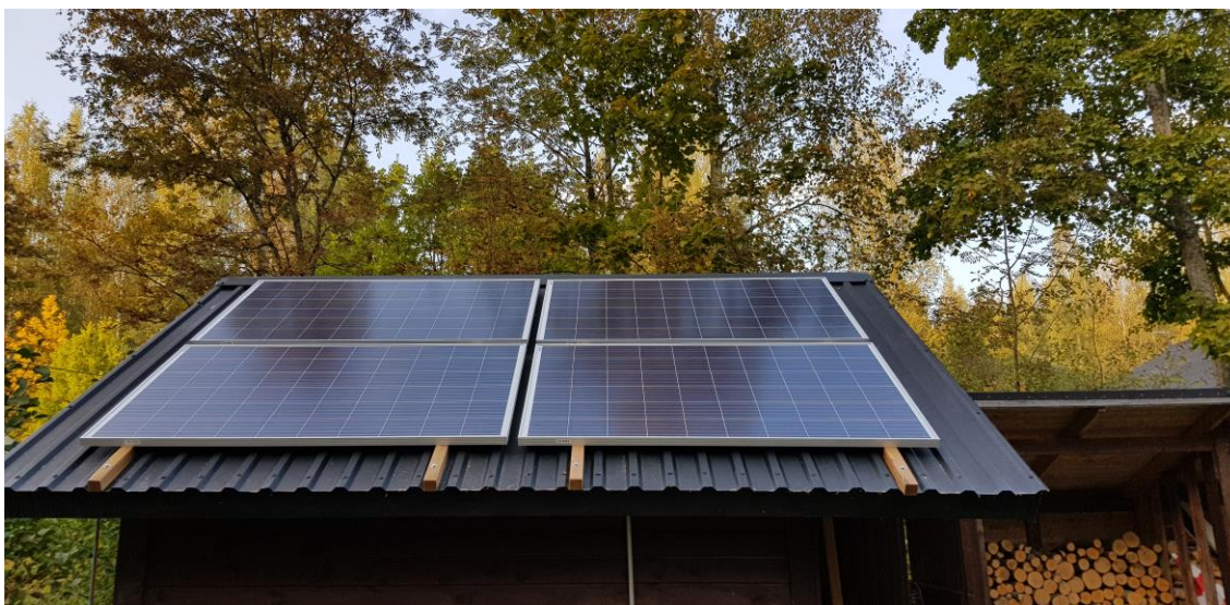
Kuva 34. Aurinkopaneelit asennettuna kattoon kiinni.
