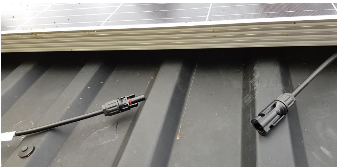
Kuva 35. Aurinkopaneelien johdotusta ennen kytkentää.
