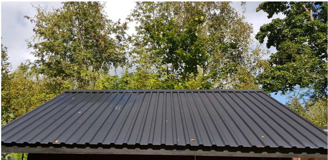
Kuva 27. Peltikaton aaltorakenne.
