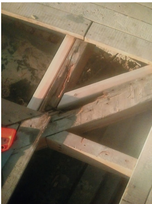
Kuva 12 Kastuneen kattoniskan vaihto. Kuva Juha Heino
