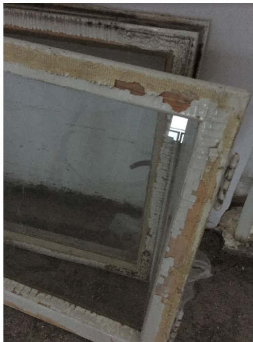
Kuva 17 Paksu kerros vanhaa maalia poistettiin ja ikkunat maalattiin uudelleen. Kuva Juha Heino
