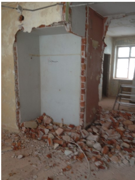
Kuva 18 Keittiön väliseinän purkamisen käynnissä. Kuva Juha Heino
