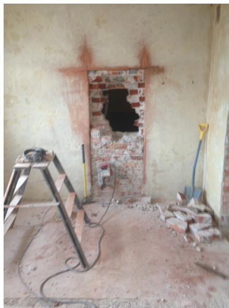
Kuva 19 Keittiön ja autovajan väliin tehtiin oviaukko kulkemisen helpottamiseksi. Kuva Juha Heino
