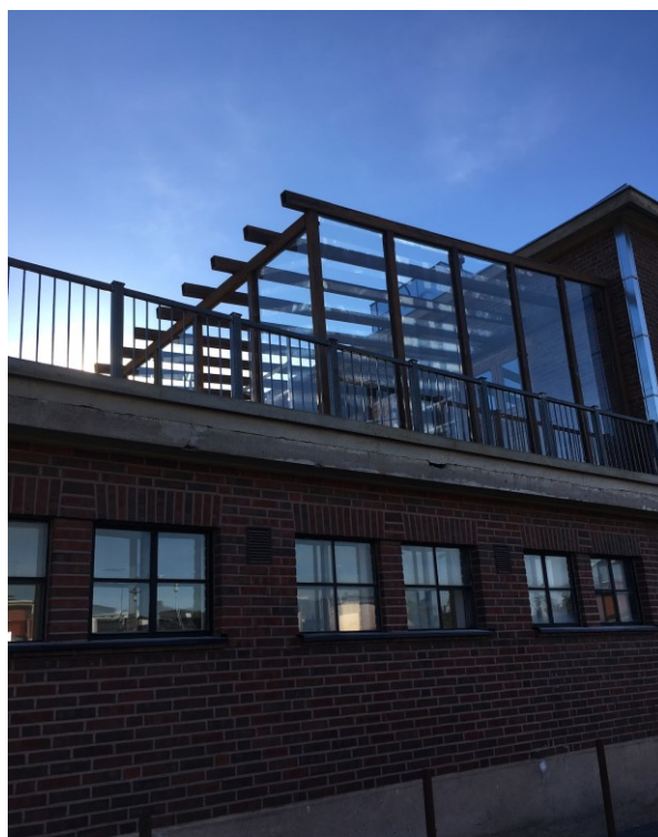
Kuva 11 Terassin rakenne valmiina. Kuva Juha Heino
