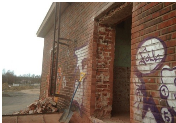
Kuva 20 700mm paksuun seinään tehtiin kaksi oviaukkoa, jotka toimivat kulkuteinä uudelle terassille. Kuva Juha Heino
