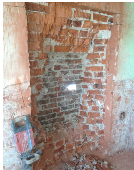
Kuva 21 Terassin oviaukon piikkaustyöt kesken. Kuva Juha Heino
