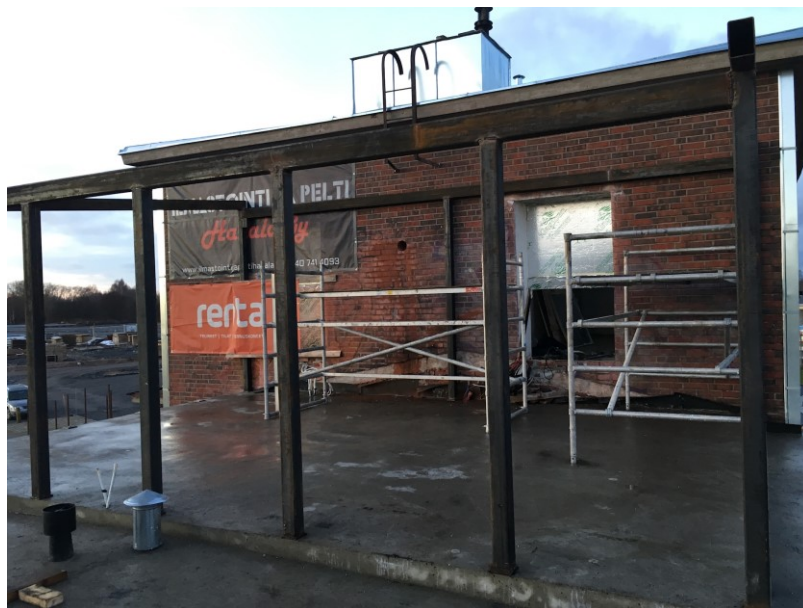
Kuva 10 Terassin rakentaminen. Kuva Juha Heino
