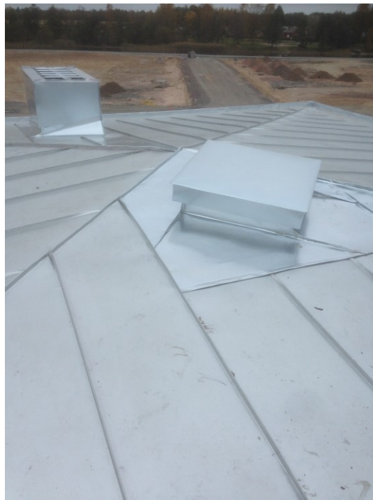
Kuva 13 Valmis Saumapeltikatto. Kuva Juha Heino
