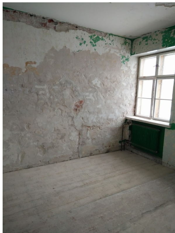
Kuva 29 Vanha irtonainen rappaus poistettu seinästä. Kuva Oliver Heino
