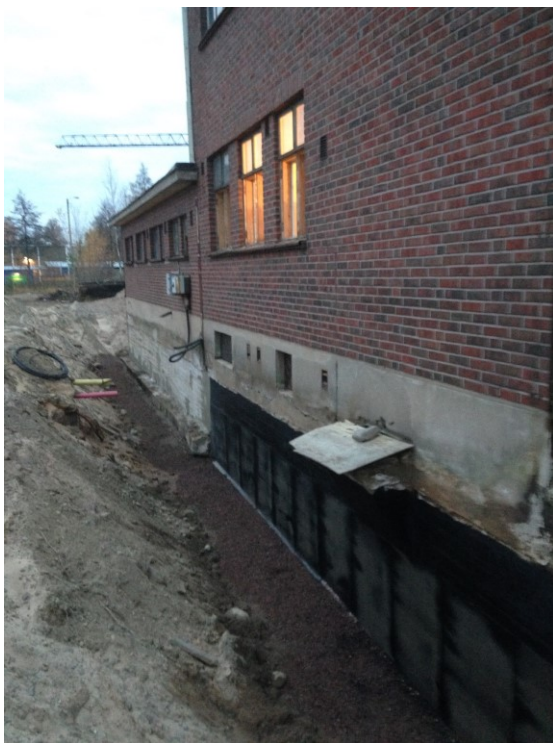
Kuva 14 Salaojatyö on kesken. Kuva Juha Heino
