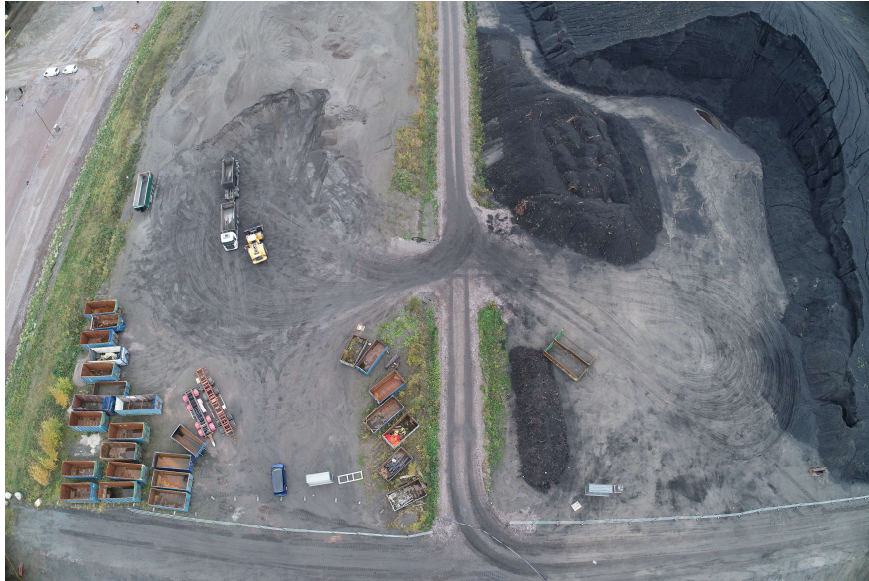
Kuva 12. Vuosaaren pohjatuhkavarasto kuvassa vasemmalla (Helen Oy)
