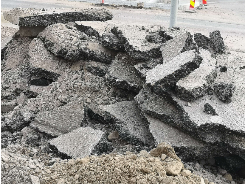
Kuva 2. Asfaltin purkutöistä syntyvä asfalttijäte
