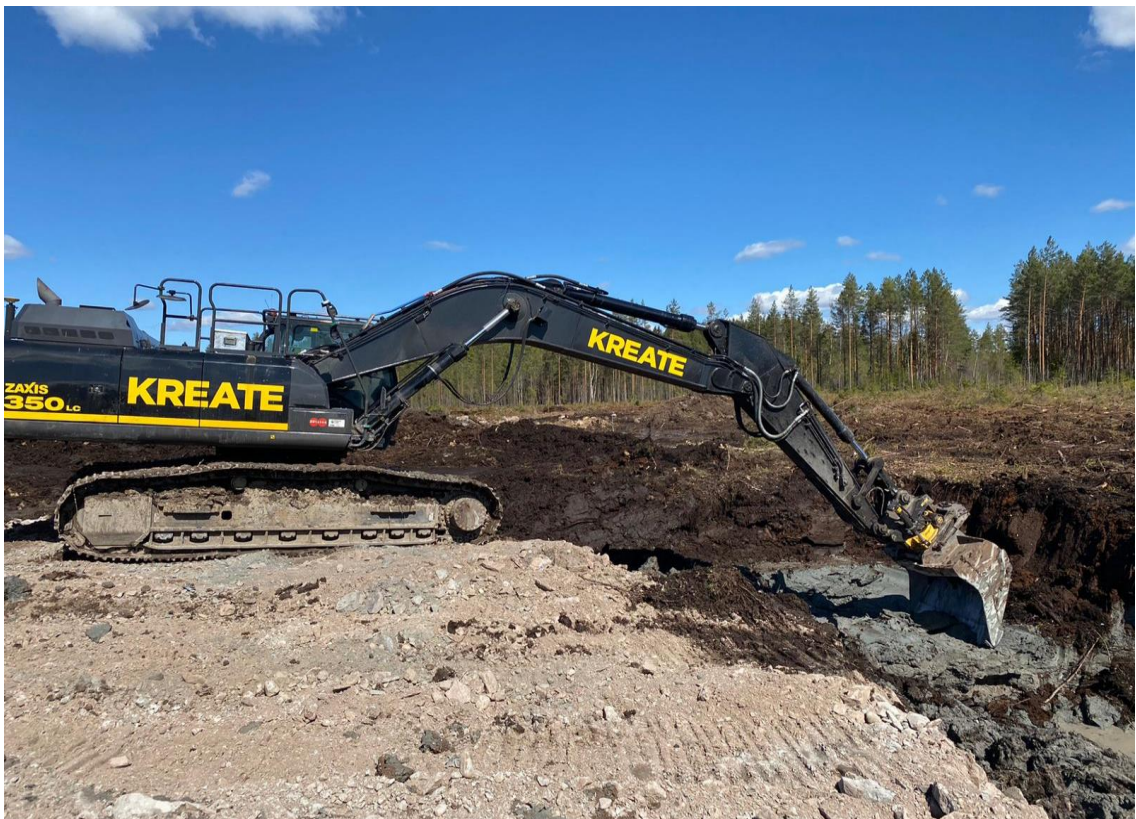
Kuva 9. Turpeen ja saven poistoa tukipenkereen pohjarakenteiden alueilta
