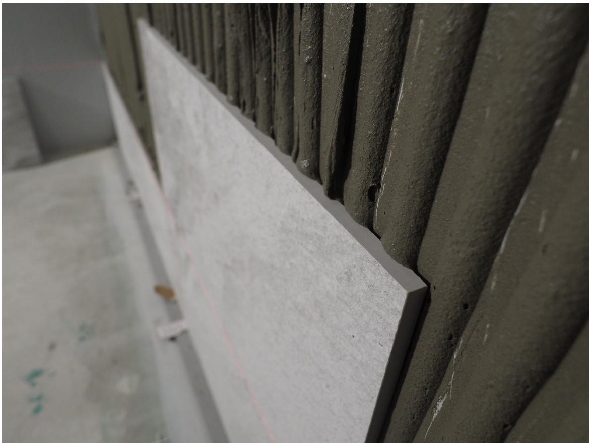
Kuva 7. Isojen seinälaattojen asennus. (Vellun Remonttityöt 2019).
