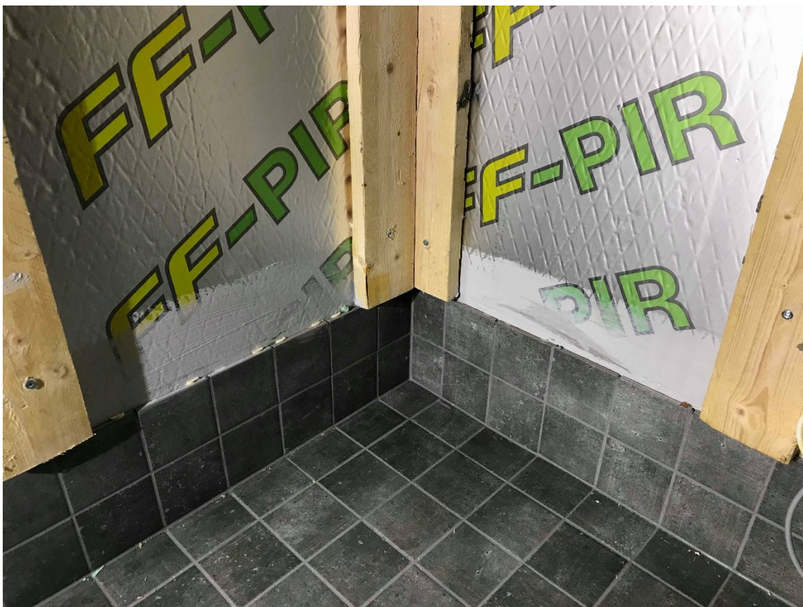
Kuva 6. Huolellisesti toteutettu saunan lattia ja nostot. (Vellun Remonttityöt 2018).
