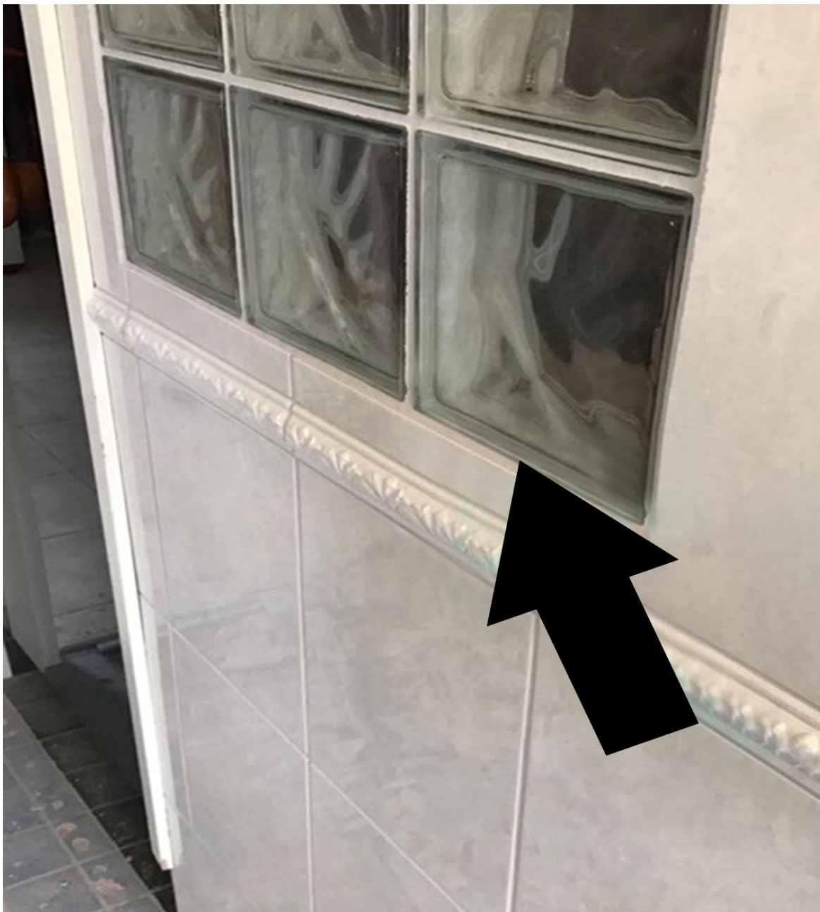
Kuva 15. Vedeneristeen reuna. (Vellun Remonttityöt 2018).
