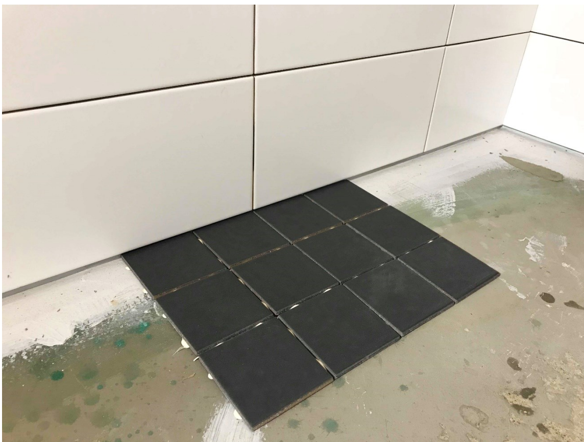
Kuva 9. Seinälaatoitus ehjillä alalaatoilla. (Vellun Remonttityöt 2016).
