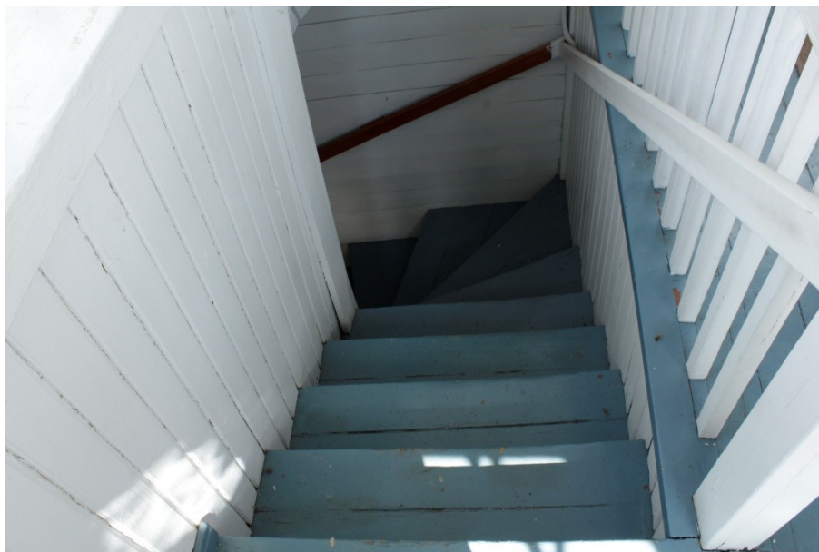
Kuva 26. Tornikabinetin lattiaa ja portaikkoo (Laulainen 2020)
