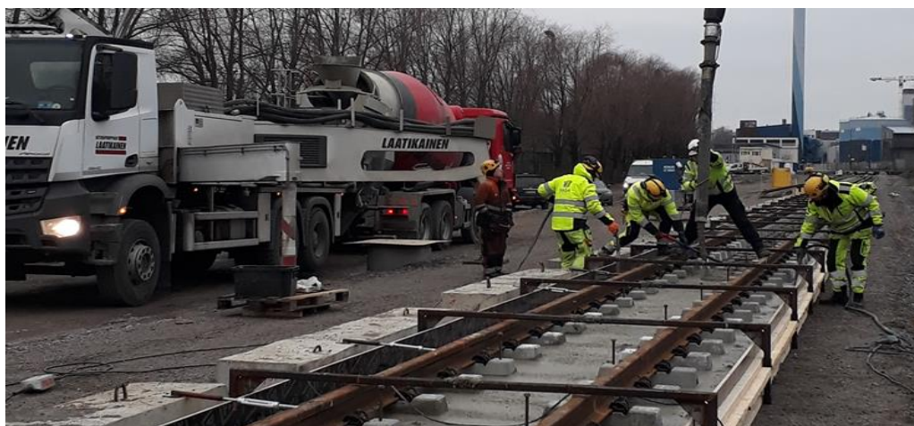
Kuva 21. Kiintoraidelaatan valu
