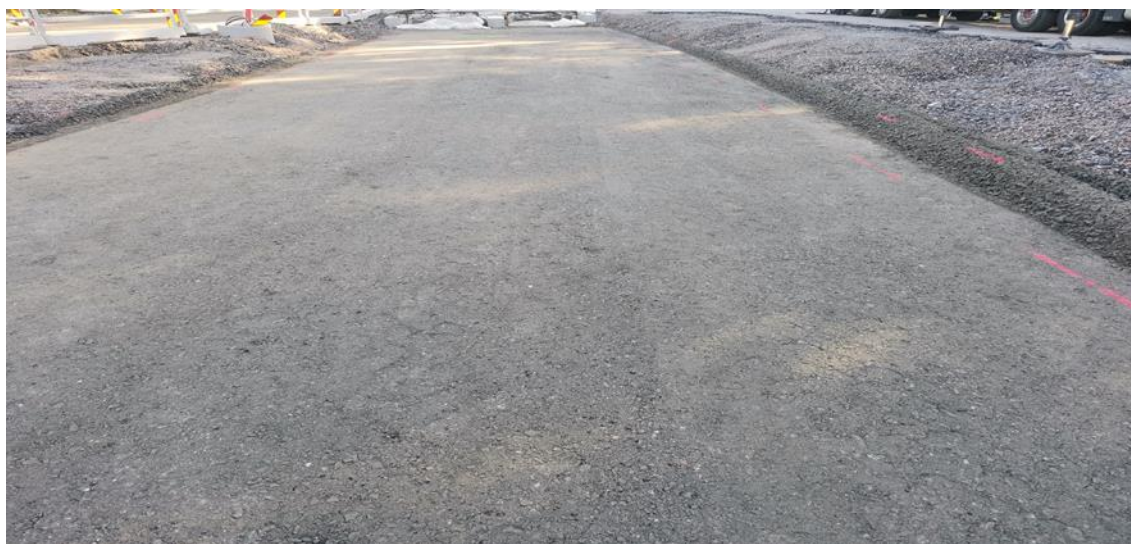
Kuva11. Hyväksytty laatanpohja ja mittamiehen merkinnät
