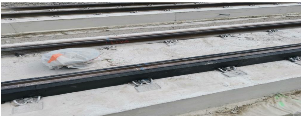
Kuva 16. Kiskot mihin asennettu kumit paikoilleen
