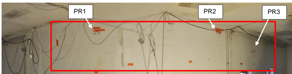
Kuva 6. Pintakosteusmittarilla rajataan tarkemmin tutkittava alue. Porareikien sijainnit tehtävä eri korkoihin ja sijainteihin, jotta saadaan tehtyä mahdollisimman paljon johtopäätöksiä tuloksista.
