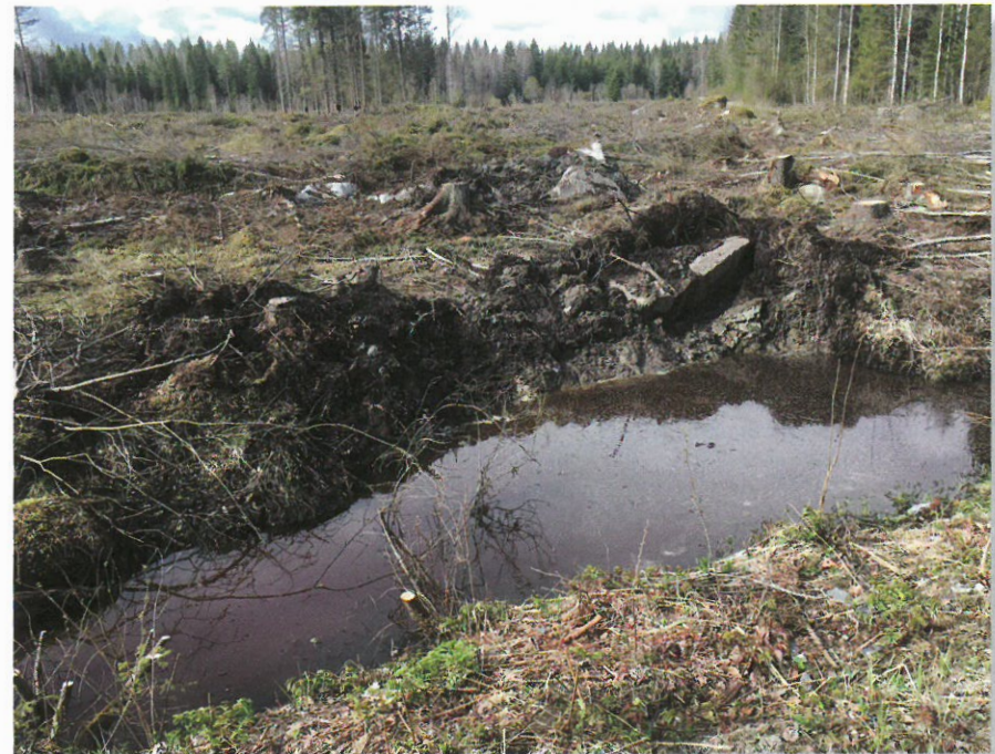
Koneyrittäjän kaivama vesikuoppa.
