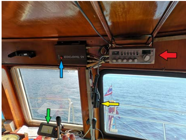
Kuva 4 Päiväveneen komentosillan CB-radio ja sen mikrofoni sekä AIS-laitteen hätähälytyspainike ja laitteeseen liitetty karttaplotteri värillisin nuolin havainnollistettuina (Haapakka 2020)
