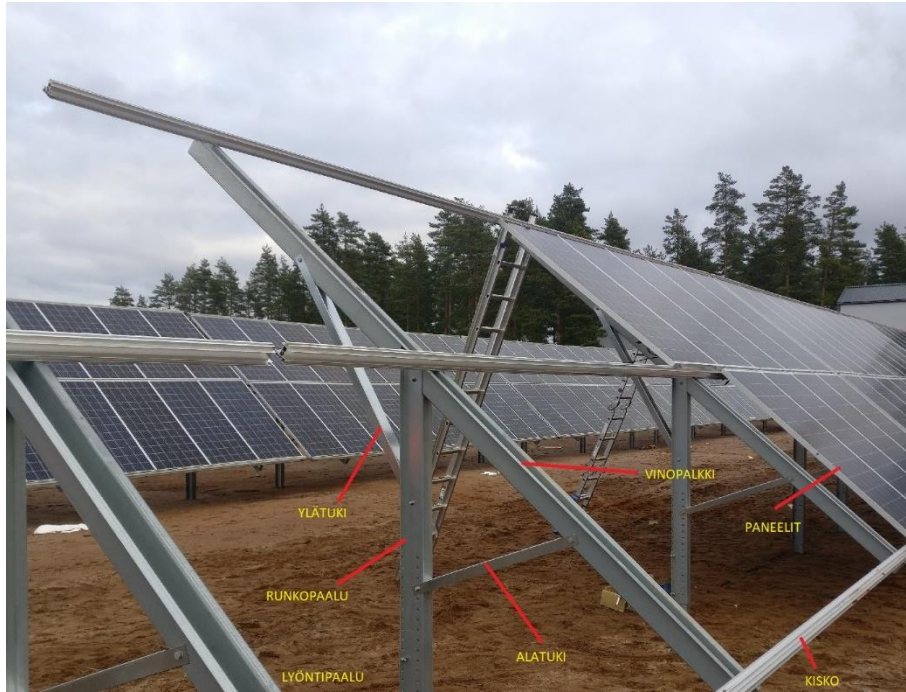
Kuva 16 Orima BEETA DOUBLE maa-asennustelineen osat
