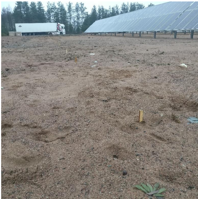
Kuva 9 Paalutuksen merkkikepit
