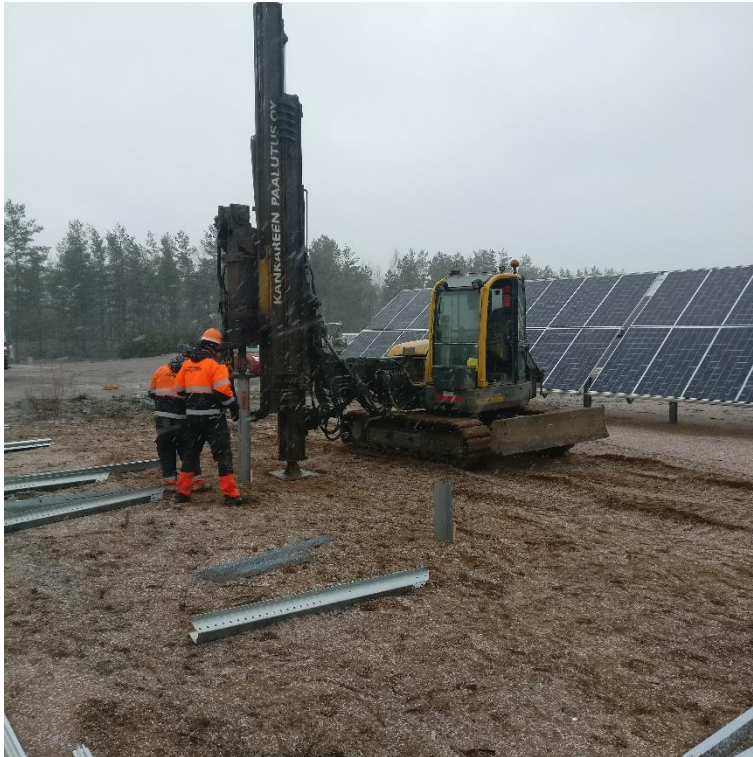
Kuva 12 Kaivinkone ja paalutus lisäosa
