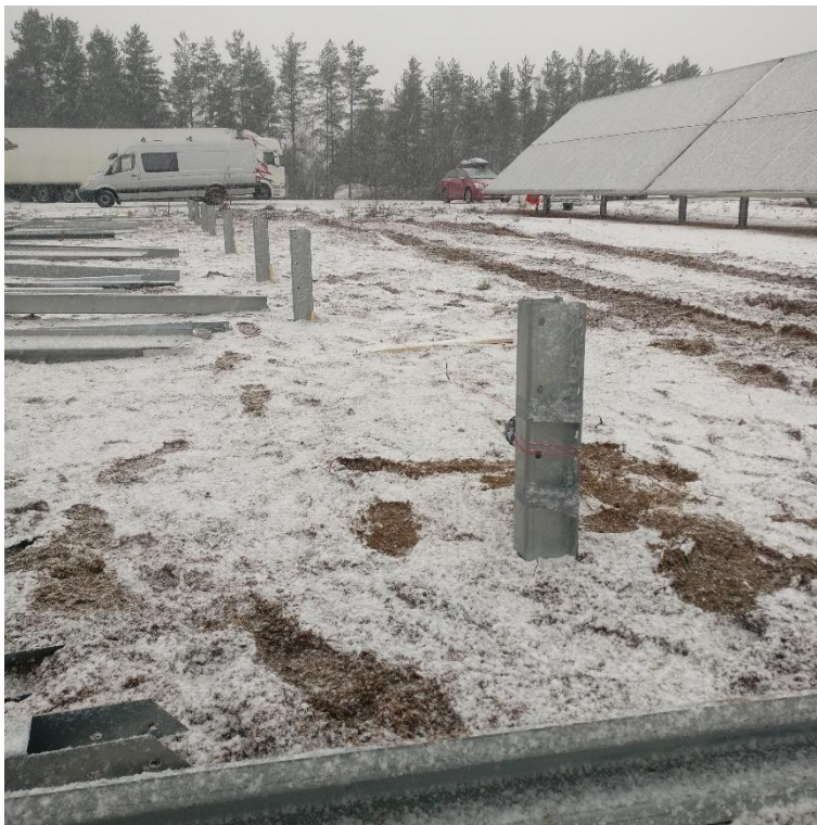
Kuva 14 Asennettu paalurivi
