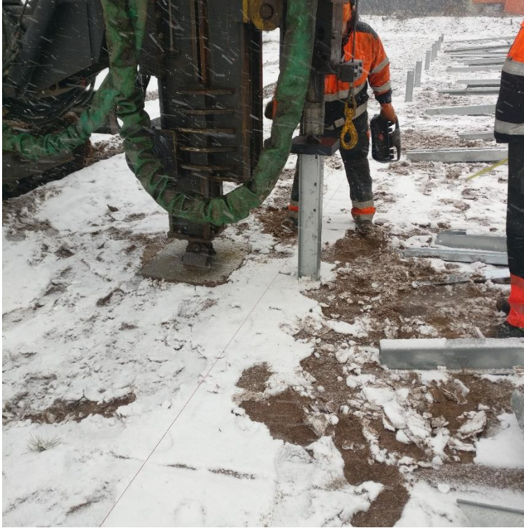
Kuva 13 Paalutuskoneen ja paalun välissä oleva välikappale
