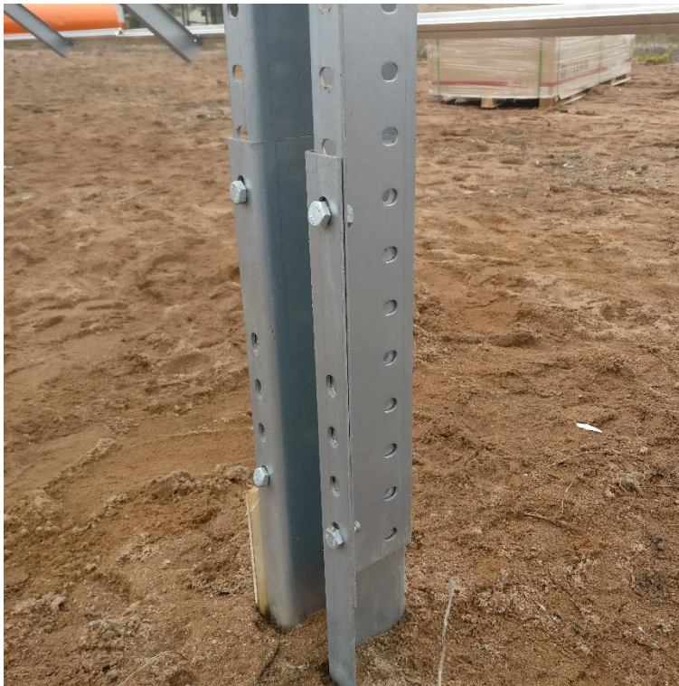
Kuva 15 Lyöntipaaluun kiinnitetty telineen runkopalkki
