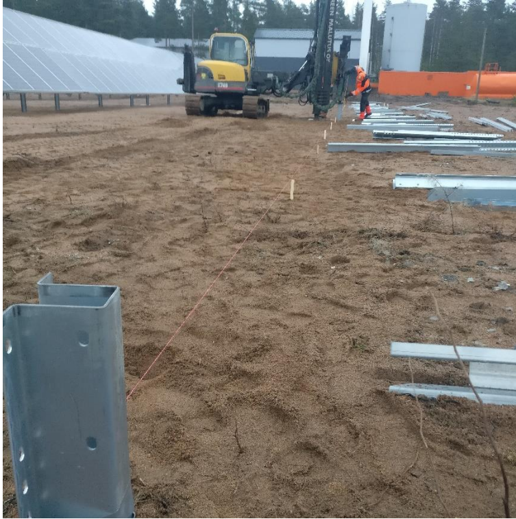
Kuva 10 Paalujen välille pingotettu linja lanka
