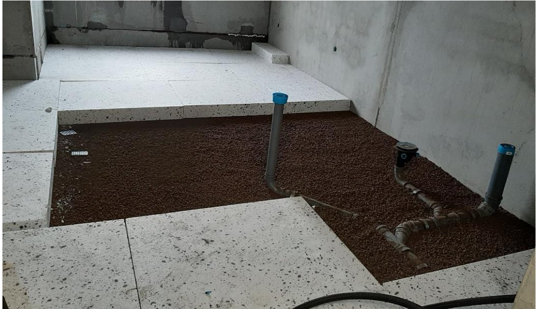
Kuva 12. Ensimmäinen EPS-kerros asennettuna kevytsoran päälle
