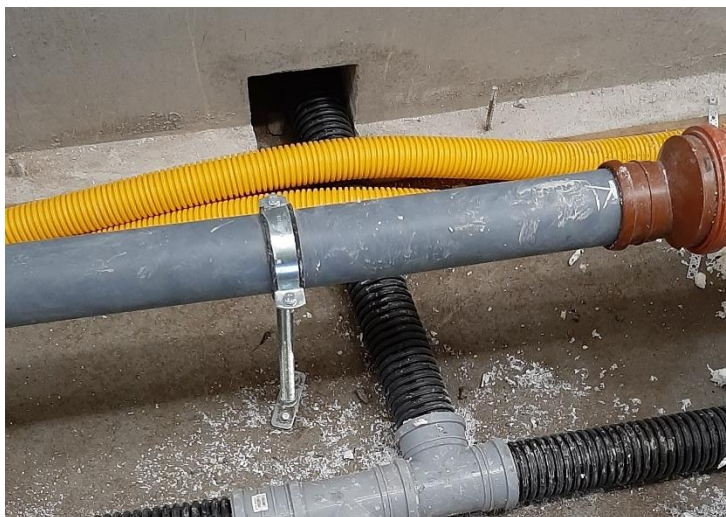
Kuva 17. Varausaukko tuuletusputken läpiviennille
