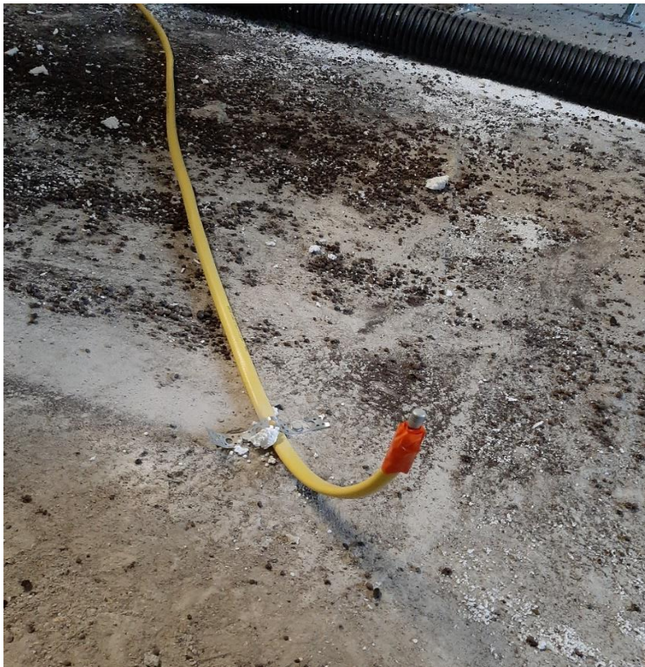
Kuva 24. Suoja-putkessa oleva Wiiste SH4-anturi ennen kevytsoran puhallusta
