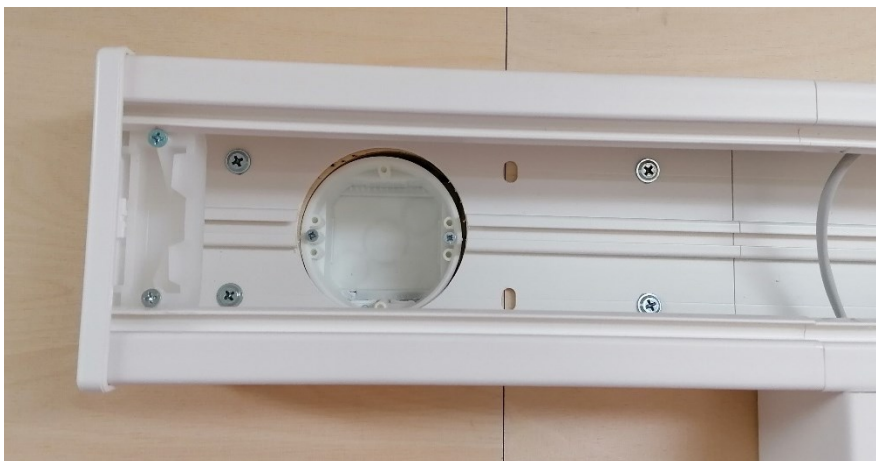
Kuvio 7. Kojerasia johtokanavan alle asennettuna
