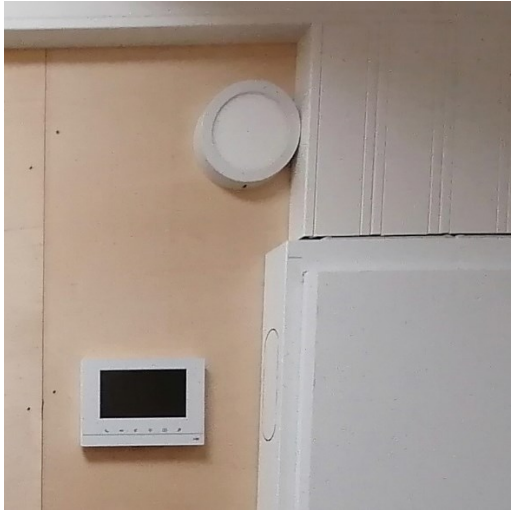
Kuvio 5. Paneelin asennus valmiina
