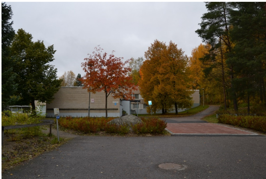
KUVA 8. Nykyinen huoltotie kulkee tontin itäreunaa, kuva etelästä katsottuna (Ruotsalainen 2019)
