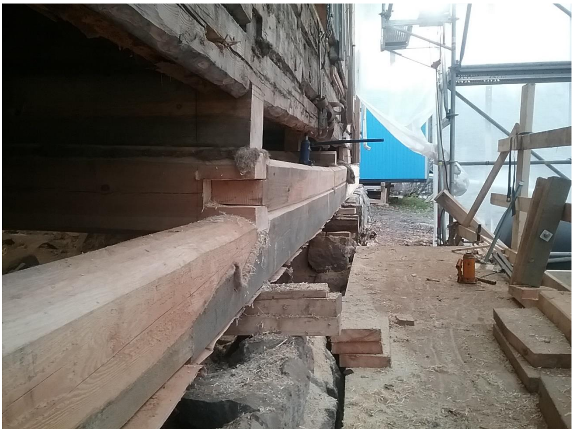
Kuva 22. Länsisivu, asennus jatkuu, väliseinähirret asennetaan samaan aikaan, 1.11.2017 (Kaikkonen)
