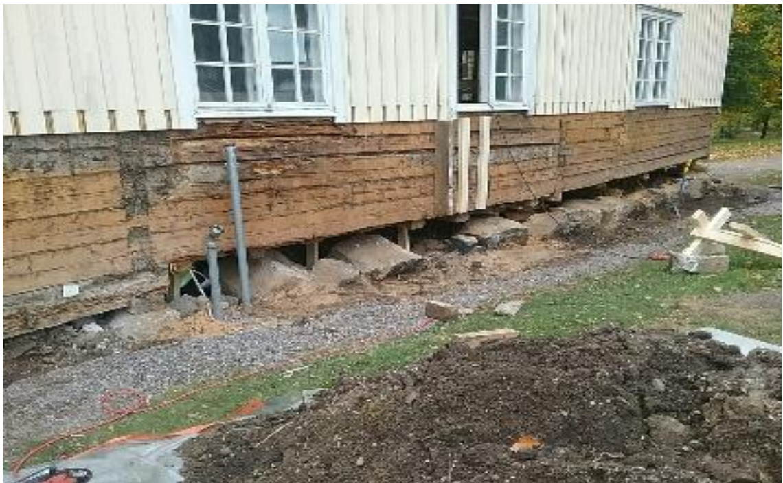
Kuva 8. Hirsityö aluillaan, itäsivu. Huomioi ikkunoiden alaosat, jäljellä myös vanha öljysäiliö, joka poistettiin lokakuussa. 26.9.20217 (Kaikkonen)
