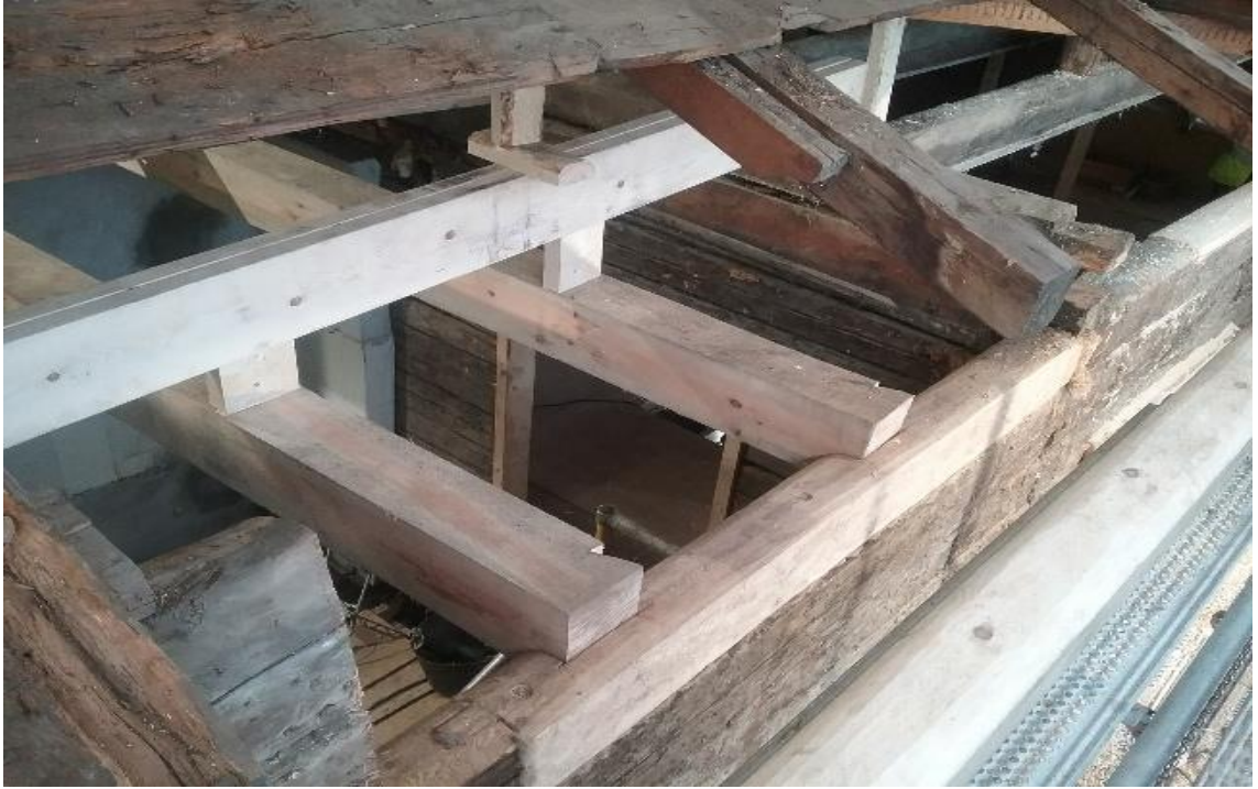
Kuva 29. Itäsivu, vanhan keittiön kohta, mittavat kosteusvauriot korjattu ja uudet kattotuennat asennettu, työt vielä hieman kesken. Tuolienpäiden korjaus seuraavana. korjaukset suoritettu perinnerakentamista kunnioittaen, 16.1.2018 (Kaikkonen)
