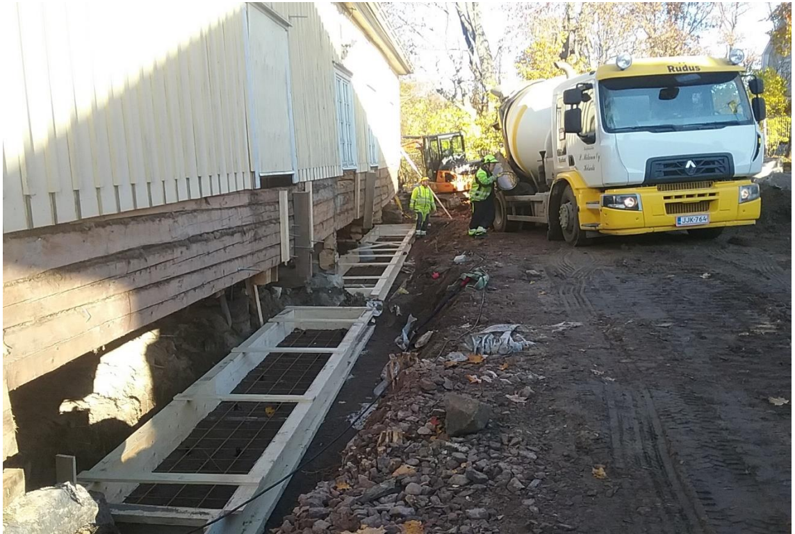
Kuva 15. Samanaikaisesti itäsivulla anturavalu meneillään. Kuvassa nähtävillä myös seinä sisäänvetokohdat, tarkoituksena suoristaa ulos pullistunutta seinää alkuperäiseen suoruuteensa, 20.10.2017 (Kaikkonen)
