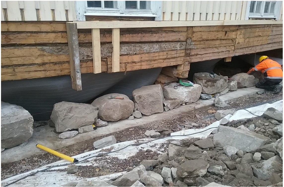
Kuva 6. Itäsivun kiviladontaa aloitettu, apuna käytetään pientä kaivuria kivien nostoon ja paikalleen asennukseen, 1.11.2017 (Kaikkonen)
