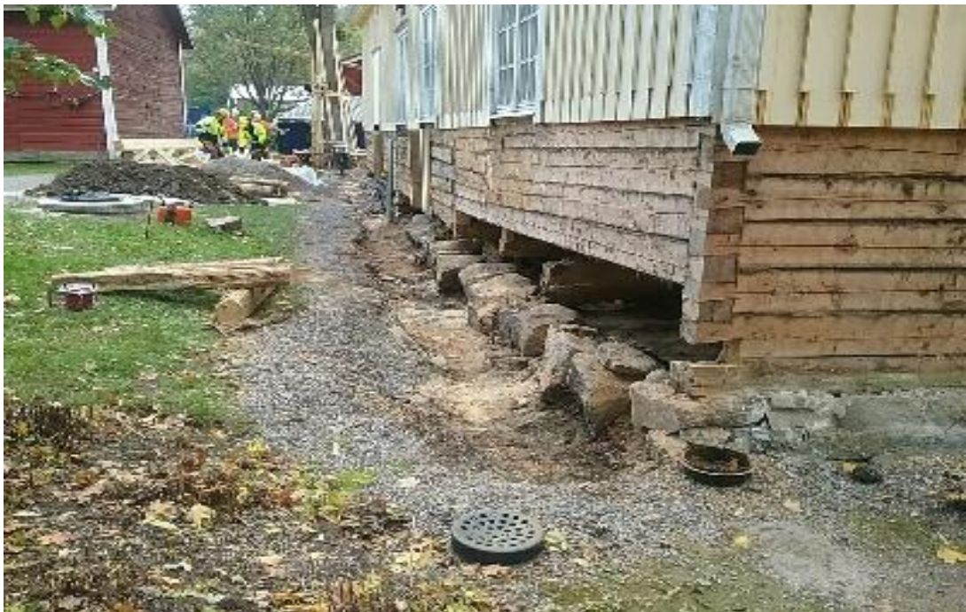
Kuva 10. Itäsivun hirsikorjaus aloitettu, 27.9.2017 (Kaikkonen)
