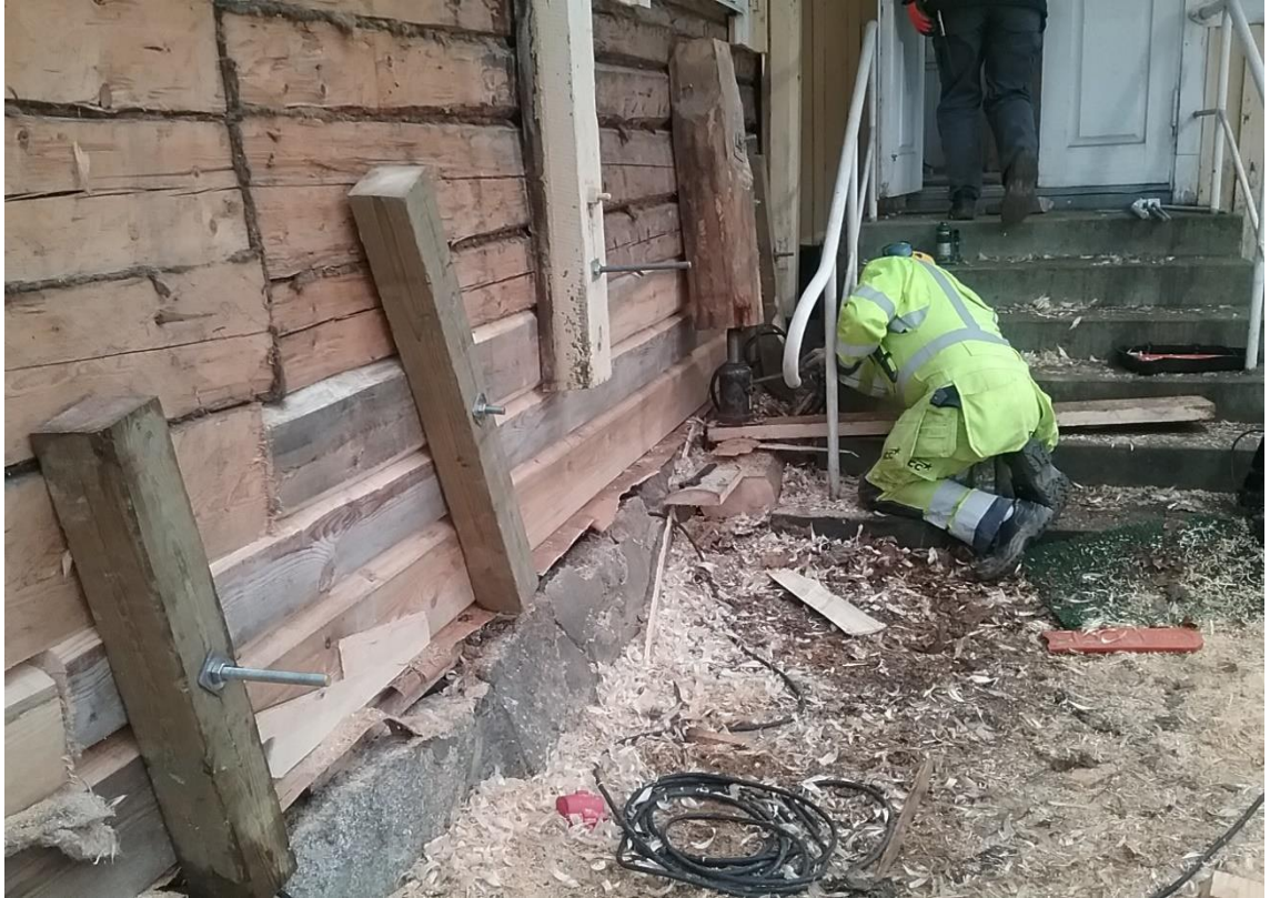
Kuva 25. Pohjoispääty valmistumassa hirsikorjauksen osalta, seinän kiristystuennat näkyvillä. Niiden avulla hirret kiristettiin kierretankojen avulla paikoilleen. Viimeisenä työvaiheena lyötiin lämpöeristeeksi pellavaa saumoihin, jolloin seinä saatiin tiiviiksi perinnerakentamisen tapaan, 21.11.2017 (Kaikkonen)
