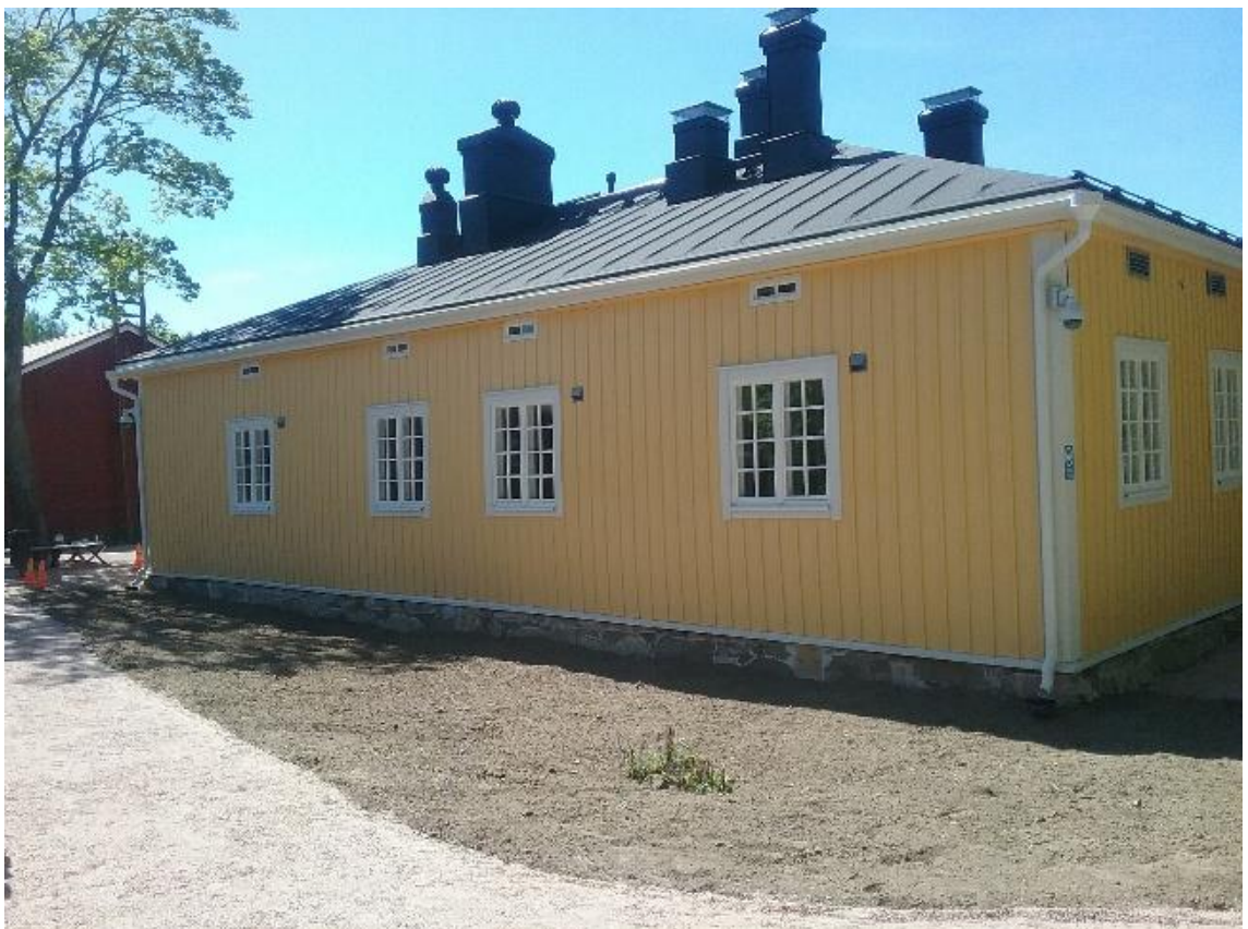
Kuva 39. Itäsivu valmiina, 25.5.2018 (Kaikkonen)
