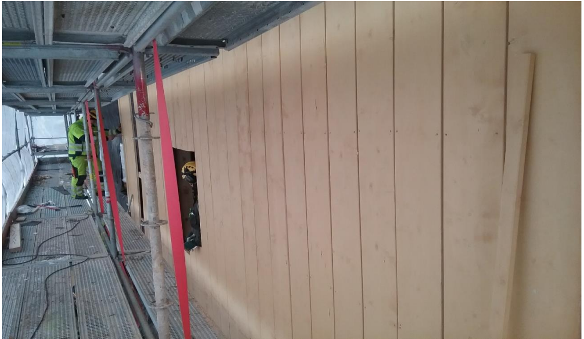
Kuva 36. Lautojen väliin jätettiin pieni elämisväli ja päälle asennettiin lista. Laudat pohjamaalattiin ja asennuksen jälkeen kahteen kertaan paikallaan, 8.2.2018 (Kaikkonen)
