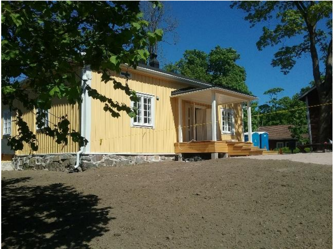
Kuva 38. Eteläpääty, valmis julkisivu, 25.5.2018 (Kaikkonen)
