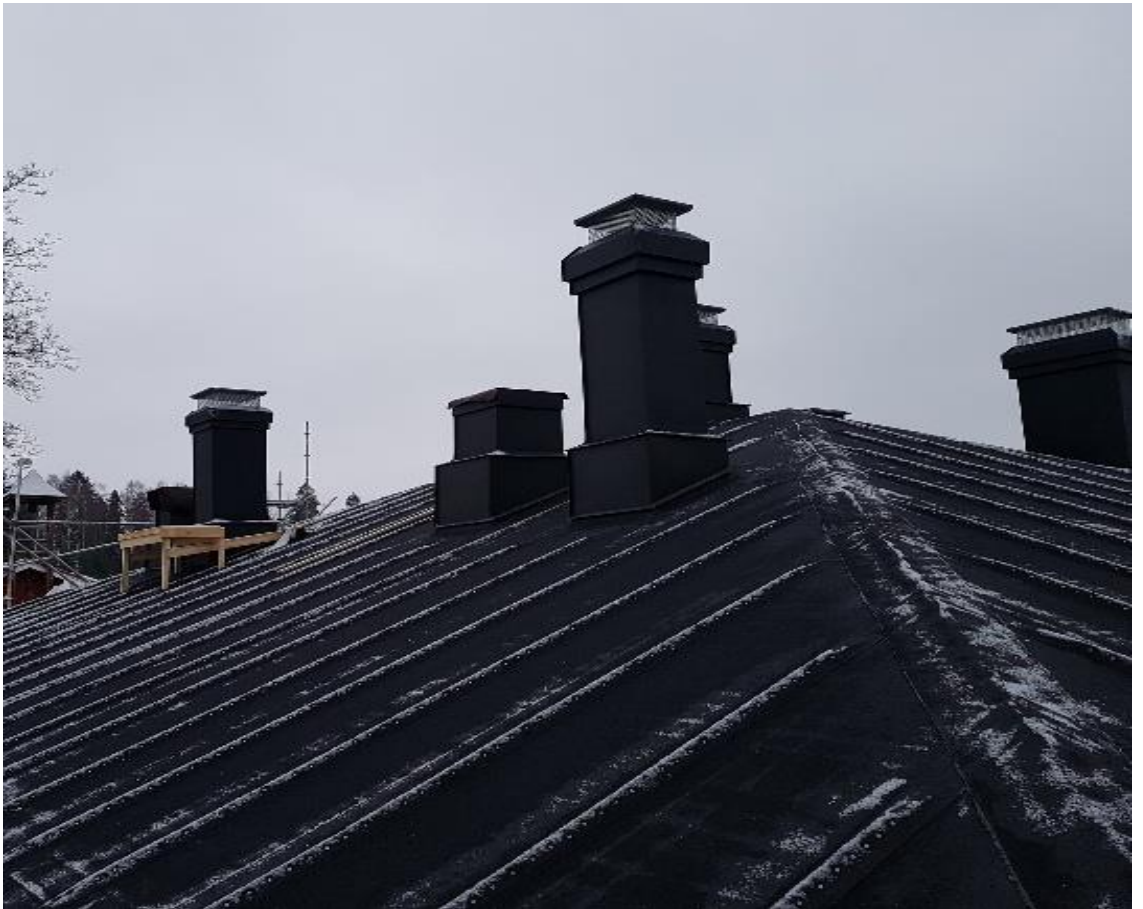
Kuva 35. Itälape, katto valmis ja piiput pellitetty. Vanhat piiput otettiin mekaanisen ilmanvaihdon avuksi, piippujen päähän asennettiin vielä tuuletuspropellit 14.3.2018 (Kaikkonen)
