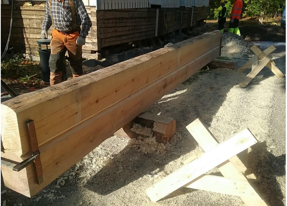
Kuva 11. Itäsivu, hirsien sovitusta ja työstöä ennen paikalleen asennuksia, 27.9.2017 (Kaikkonen)
