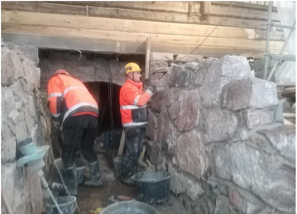
Kuva 5. Kivimuurin takaisinasennusta ja seinälinjan korjausta, saumaustyöt meneillään, 1.12.2017 (Kaikkonen)
