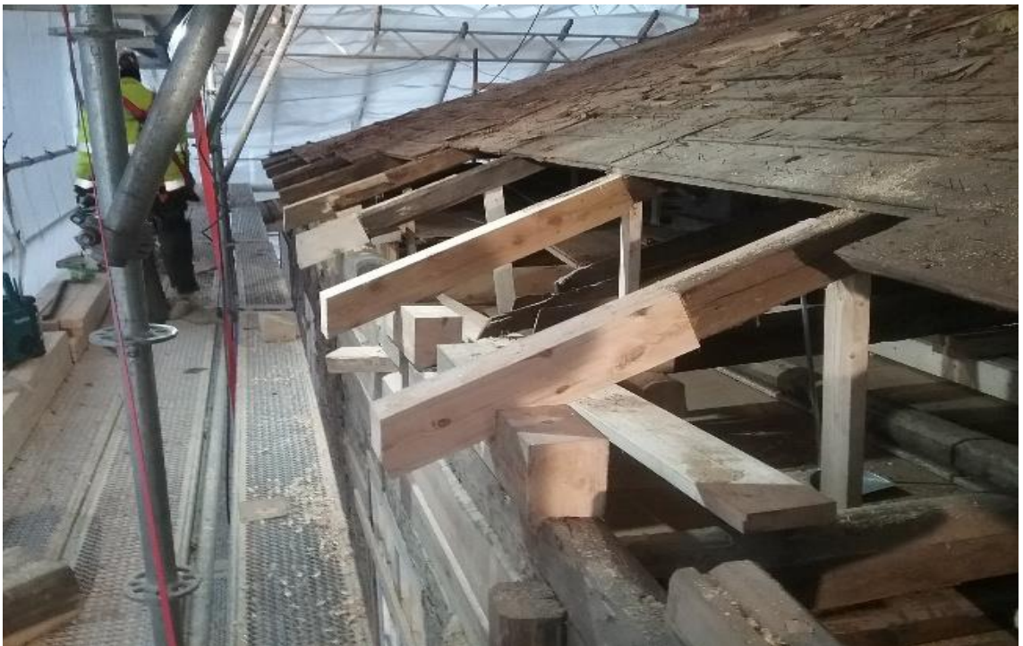
Kuva 30. Länsisivun korjauksia ja uusia tuentoja, Ylähirret olivat kauttaaltaan taipuneet sisäänpäin, oikominen toteutettiin kattotuolien päiden korjauksien yhteydessä. Vintinalueelle asennettiin lyhyet följarit tukemaan seinän yläosaa, 16.1.2018 (Kaikkonen)
