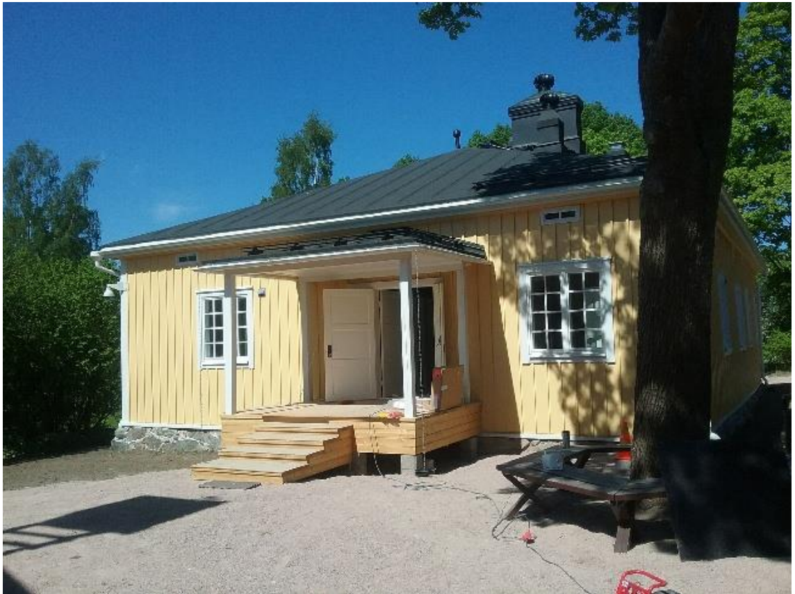
Kuva 2. Pehtorin talo, Etelä, kaiteet ja luiska vielä puuttuvat. 25.5.2018 (Kaikkonen)
