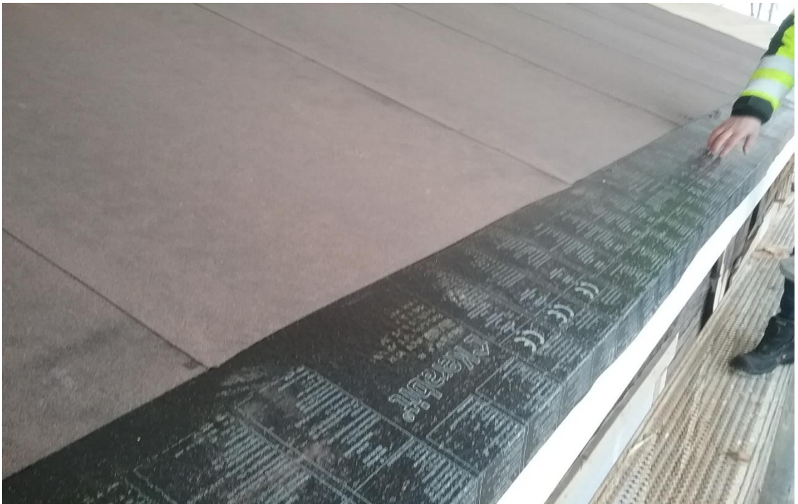
Kuva 33. Reuna- ja pohjahuopa asennettu, räystäät kunnostettu 6.2.2018 (Kaikkonen)
