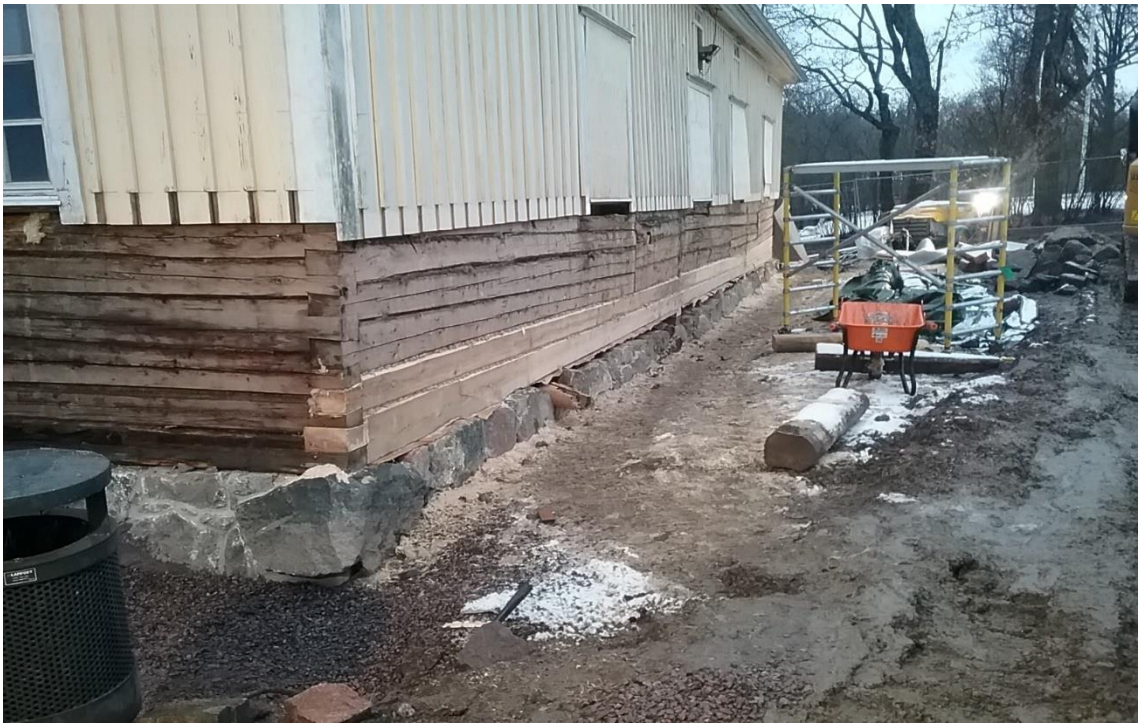
Kuva 24. Itäsvun seinää, alakivet on asennettu anturan päälle samanaikaisesti, länsisivun seinäkorjauksien kanssa. Seinäkorjaus valmiina, 20.11.2017 (Kaikkonen)
