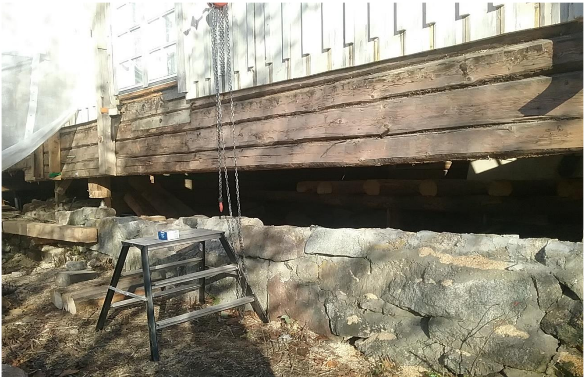
Kuva 14. Länsisivua purettuna, 20.10.2017 (Kaikkonen)
