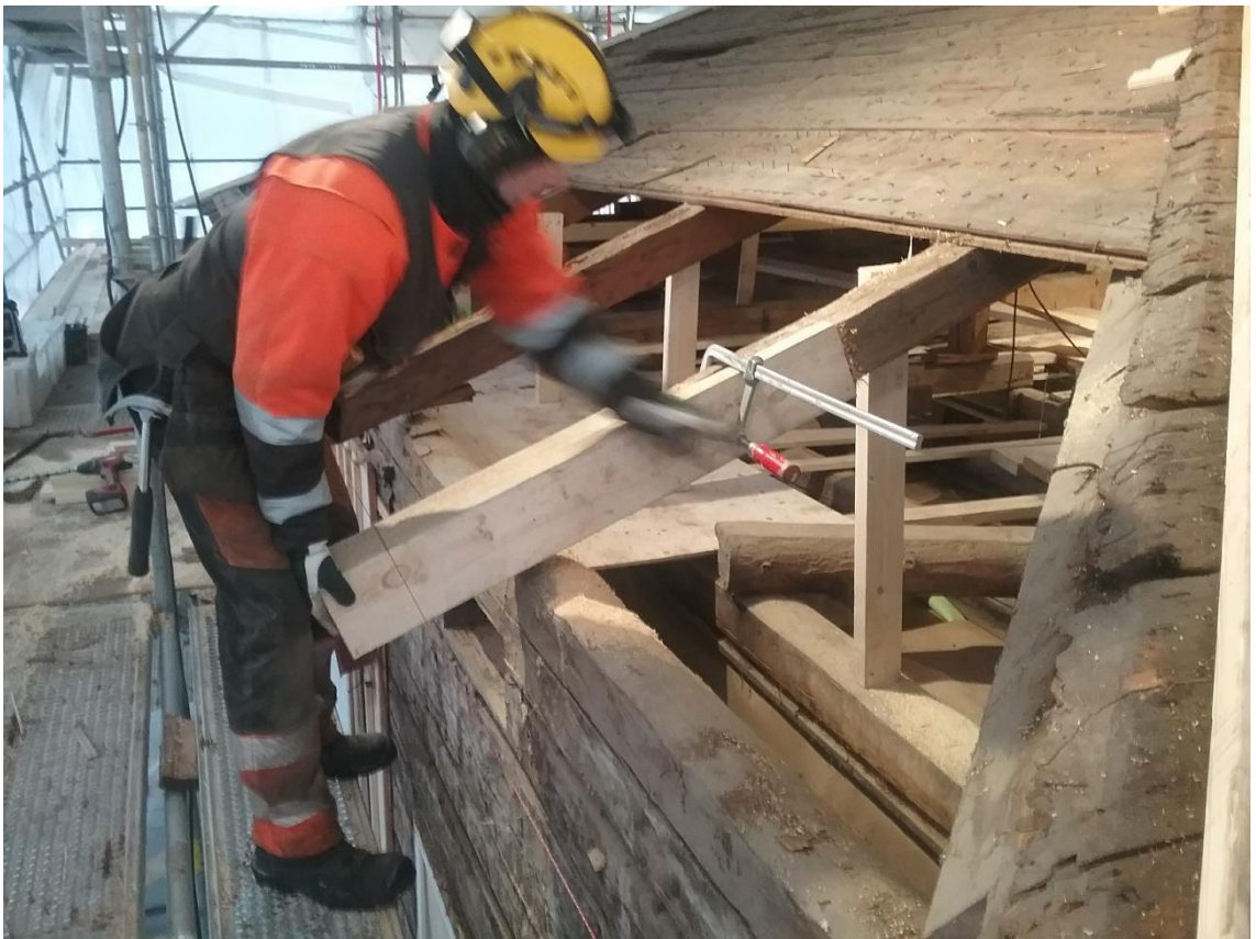
Kuva 28. Eteläsivu, kattotuolien korjaukset ja muut vintin ja tuolien vahvistukset suoritettu ja nähtävillä, 15.1.2018 (Kaikkonen)
