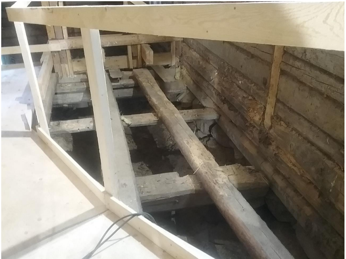
Kuva 40. Lattiat oli purettu ja vahvat lattiakannattajat olivat vielä paikallaan. ne purettiin vielä pois ja aloitettiin työt aukealta huoneen pohjalta. Kulkutiet rakennettu ja osalla aluetta, kulku portaiden kautta, 15.9.2017 (Kaikkonen)
