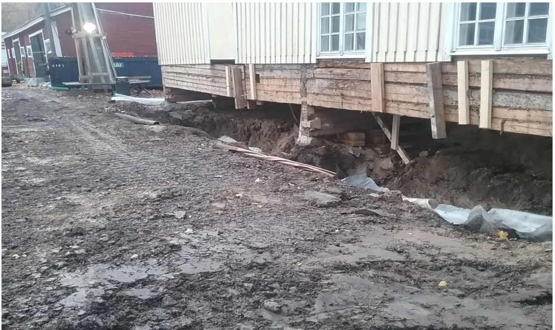
Kuva 12. Itäsivun seinän kunto havaittiin niin huonoksi ja kieroksi sekä kaarevaksi, joten päätettiin vetää seinää sisään taljojen avulla ja perustaa anturarakenteet uudelleen anturavalulla ja latoa kivet uudelleen paikoilleen. tässä vaiheessa seinän edestä on jo poistettu 5 m 3 :n öljysäiliö, siitä myöhemmin, 18.10.2017 (Kaikkonen)
