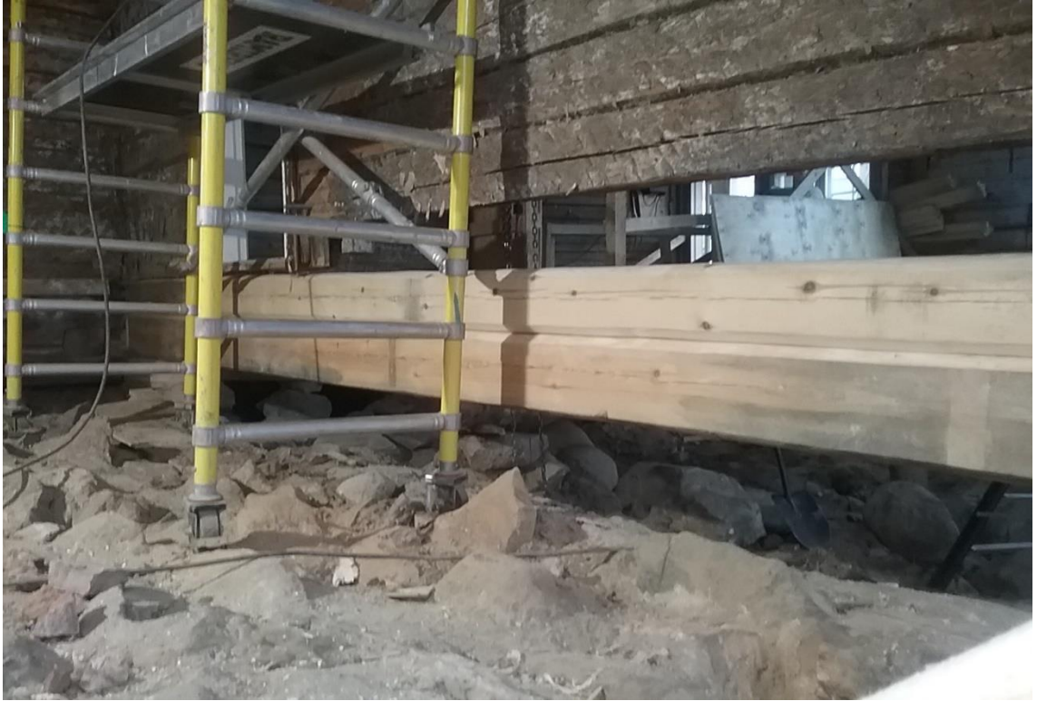
Kuva 23. Väliseinän hirret asennettiin samanaikaisesti ulkoseinätyön kanssa, tila H102- 103, 1.11.2017 (Kaikkonen)
