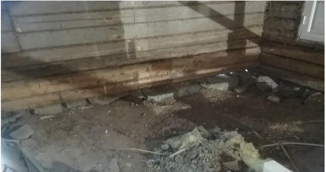
Kuva 41. Keittiö vanha sisääntulo on purettu alkutekijöihinsä. Ylimääräiset ”mujut” imuroitiin pois ja lattialle levitettiin paikoittain hieman murskettua pohjan taksauksen vuoksi, 15.9.2017 (Kaikkonen)
