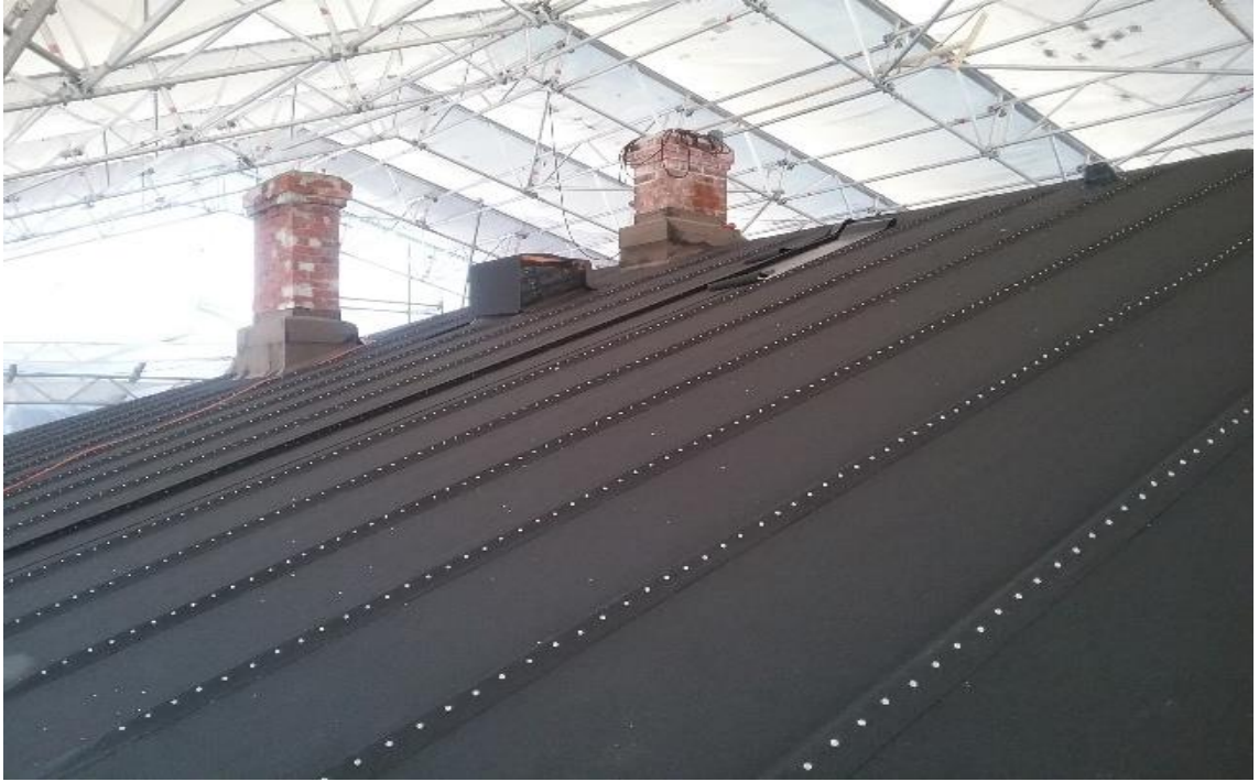
Kuva 34. Länsilape, kolmiohuopa- asennus lähes valmis, 1.3.2018 (Kaikkonen)
