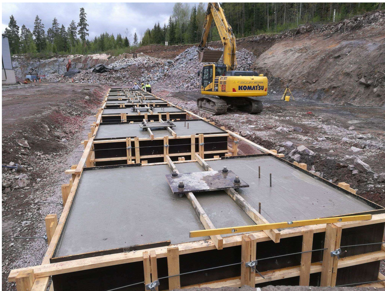
Figur 3. Bild på grundskruvar med schablon ingjutna i grundfundament. (Mittaaaja, 2015)
