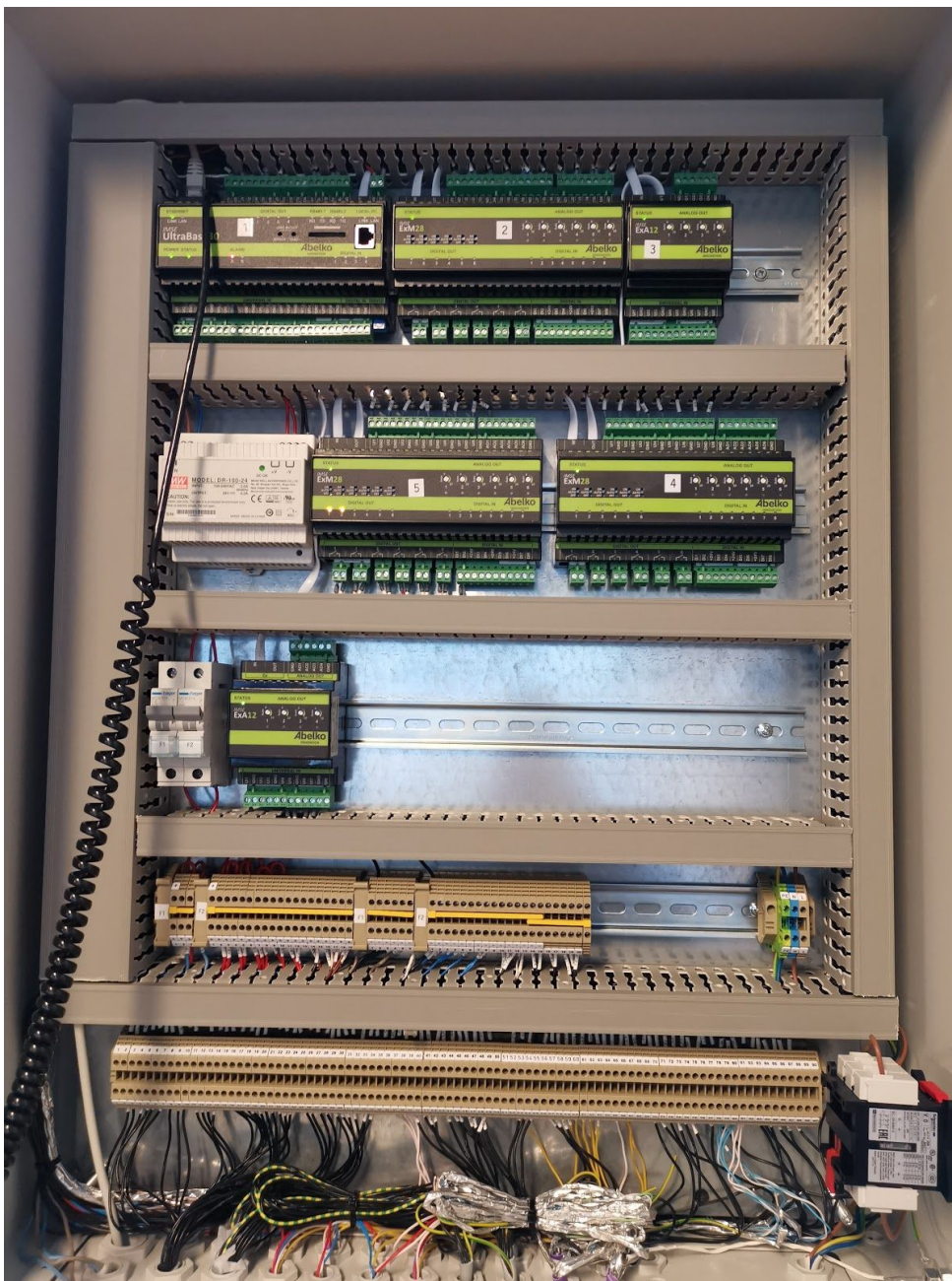
Figur 24. Det färdiga styrskåpet
