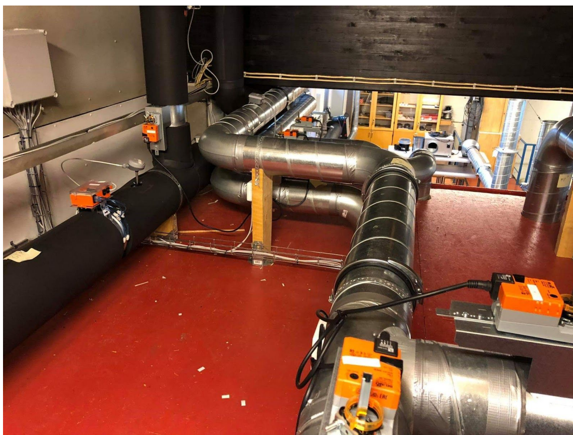
Figur 21. Kontrollrummets tak med givare och spjäll monterat, plinskåpet ses till vänster
