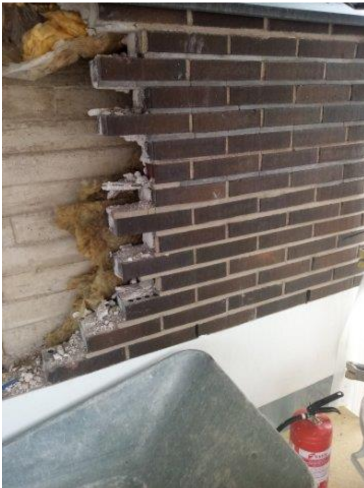
Kuva 4. Kullervonkadun toimipaikan julkisivun purkua. [28.]
