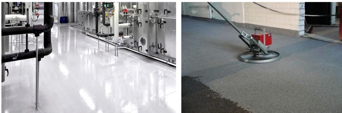
Kuva 5. Kuvissa on esitetty esimerkkejä epoksi- ja polyuretaanipinnoitteista. Vasemmalla on polyuretaani (Nanten PU Flex BIO) ja oikealla epoksinnoite (Nanten HM W epoksihier-topinnoite). [kuvat: www.nanten.fi ]
