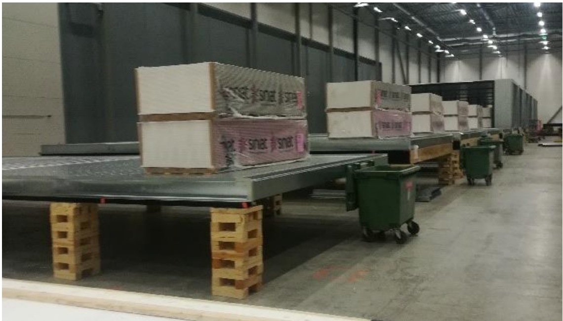
Kuva 7. Moduulien alapohjat pukkien päällä
