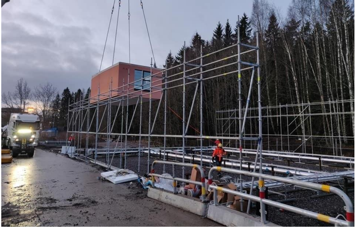
Kuva 1. Moduulin nosto työmaalla tapahtuu autonosturilla
