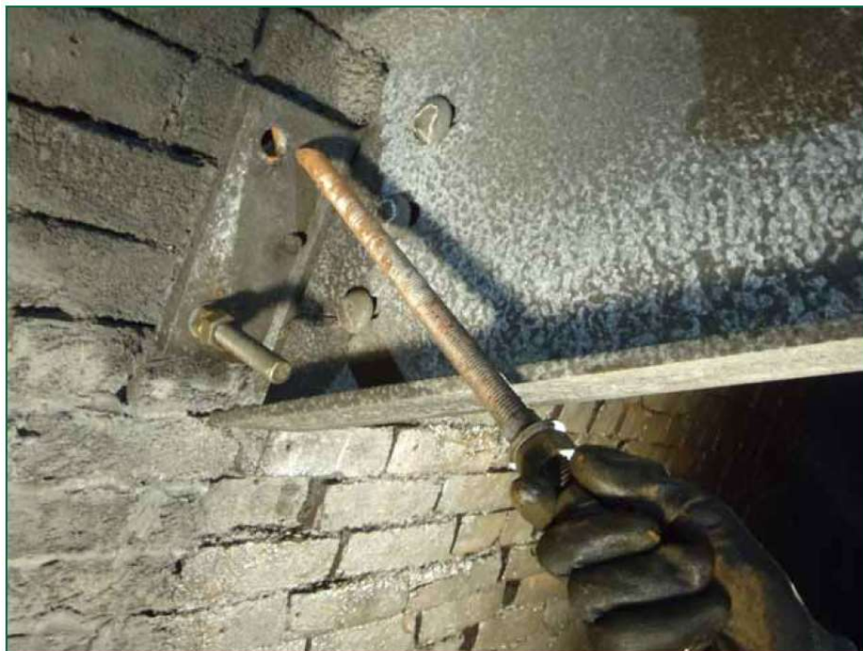
Kuva 13. Tarkastuksessa löydetty irtonainen ankkuri onnettomuuspaikan lähellä. [46.]
