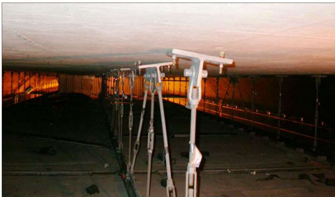
Kuva 11. Kuvassa näkyy selvästi Big Dig -tunnelin kattoelementtejä kannatelleiden kemiallisten ankkureiden tartunnan peittäminen ja ankkureiden siirtymät. [23, s.12.]
