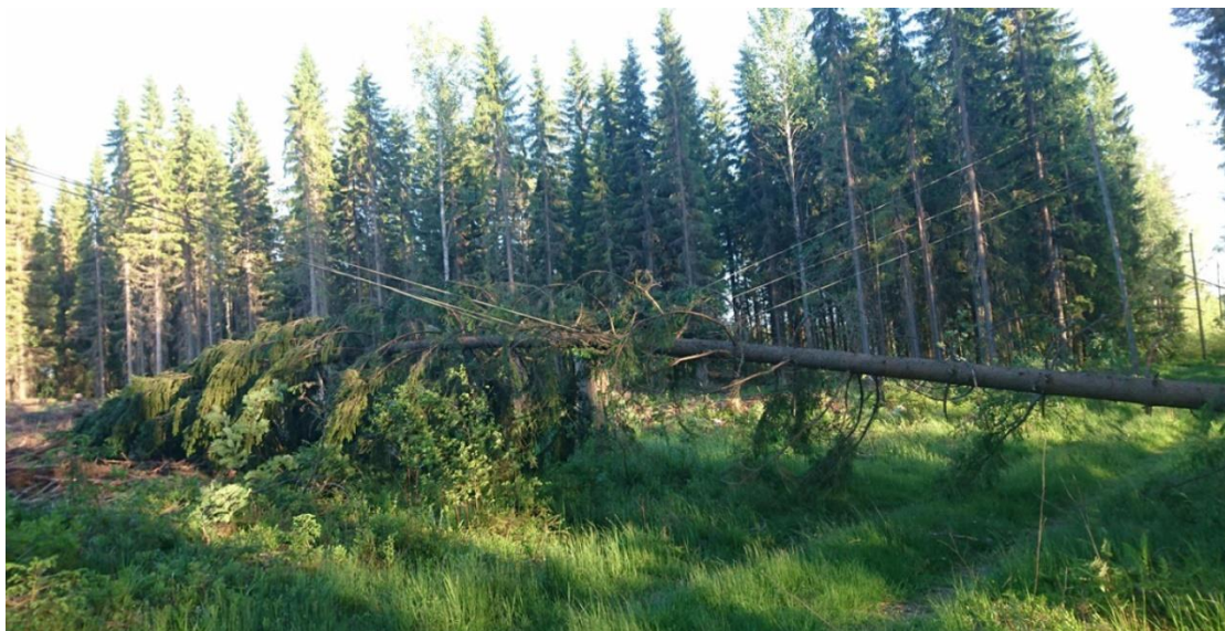
Kuva 13. Puu roikkuu keskijänniteilmajohdon varassa. Luokitukseltaan tärkeä keskijänniteverkon vikapaikka, joka on nopeahko korjata.
