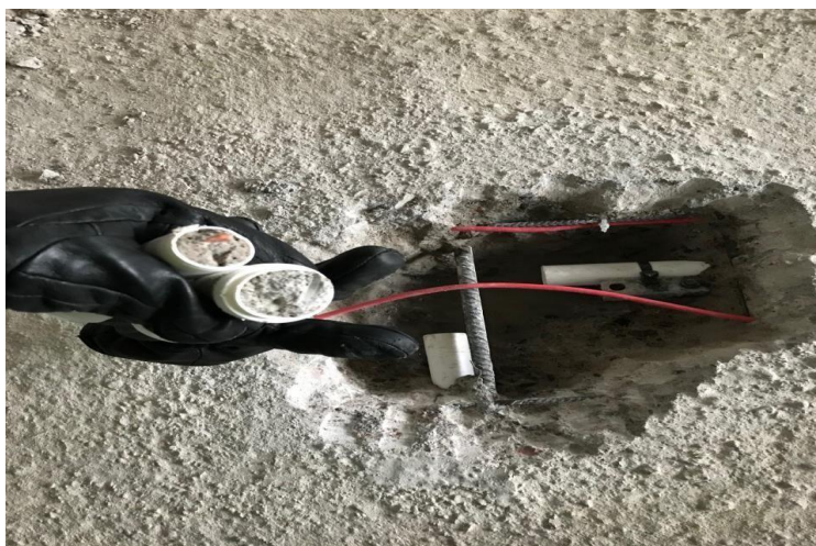
Kuva 9. Kuvassa tukkeutunut putkiliitos. (Nurminen 2019)
