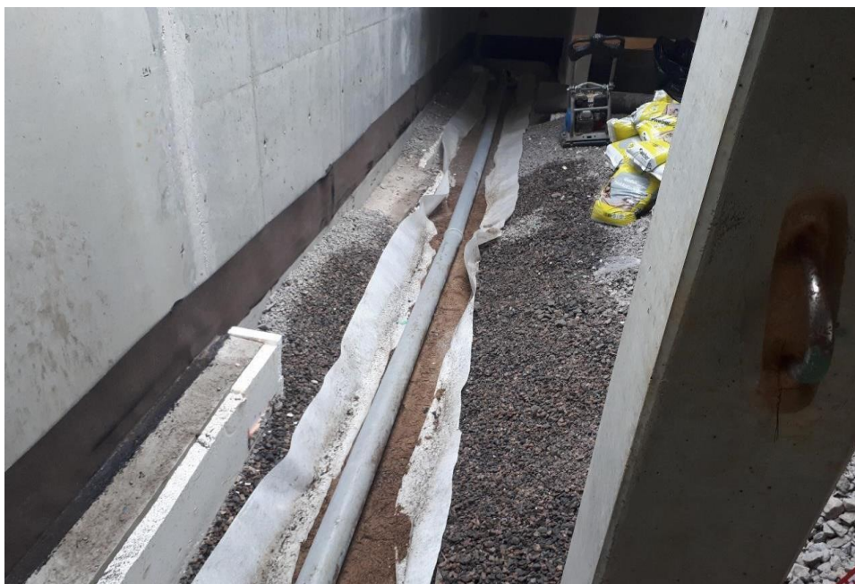
Kuva 12. Kuvassa K2 kerroksen viemäriinjan tekoa. (Nurminen 2019)
