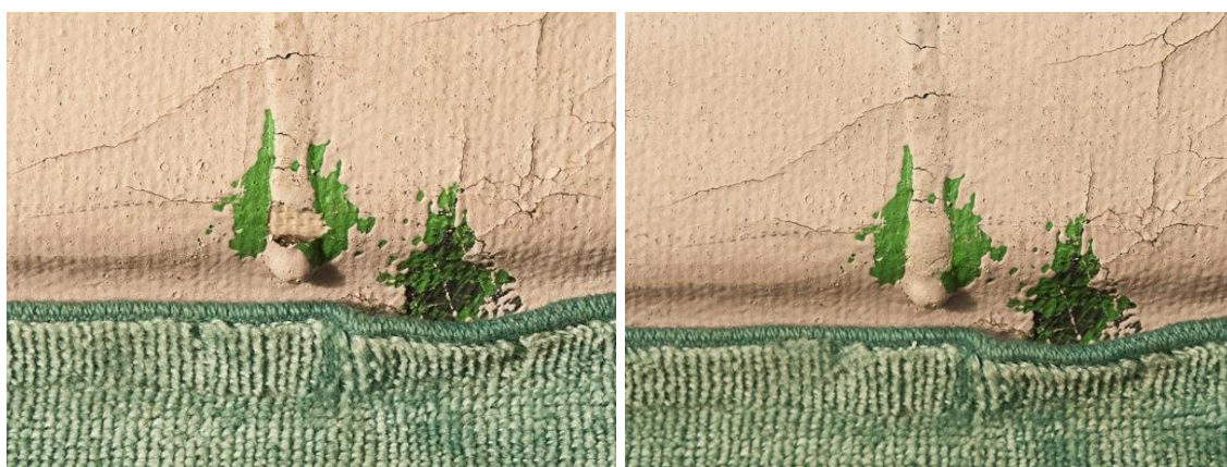
Kuva 68. Maalipinnan puutos valuma-alueella ennen ja jälkeen konservoinnin.
