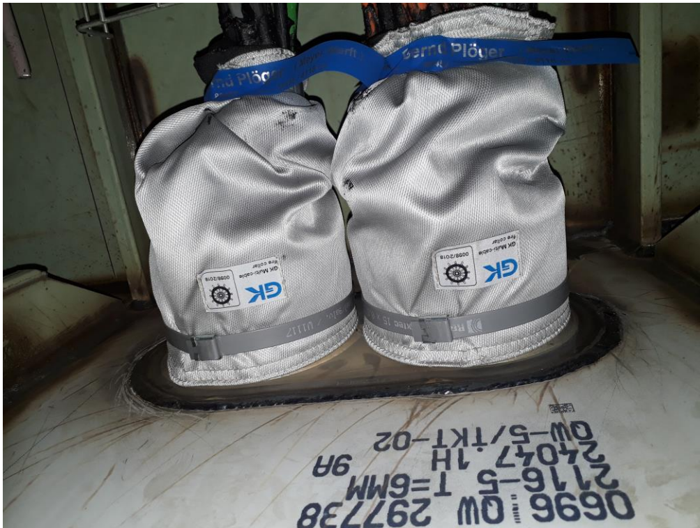
Kuva 26. Vesirajan yläpuolisten kansien Roxtec-GK kaapeliläpivienti. Kankaan sisällä on täyte kaapeleiden ympärillä, joka laajenee kuumetessaan, sekä massatäyte tiivistämään läpivienti. Ruorin kuva tarkoittaa MED- sertifioitua Marine-käyttöön. Kangaspussi suljetaan oikeaoppisesti laatutodistuksessa kerrotulla tavalla.
