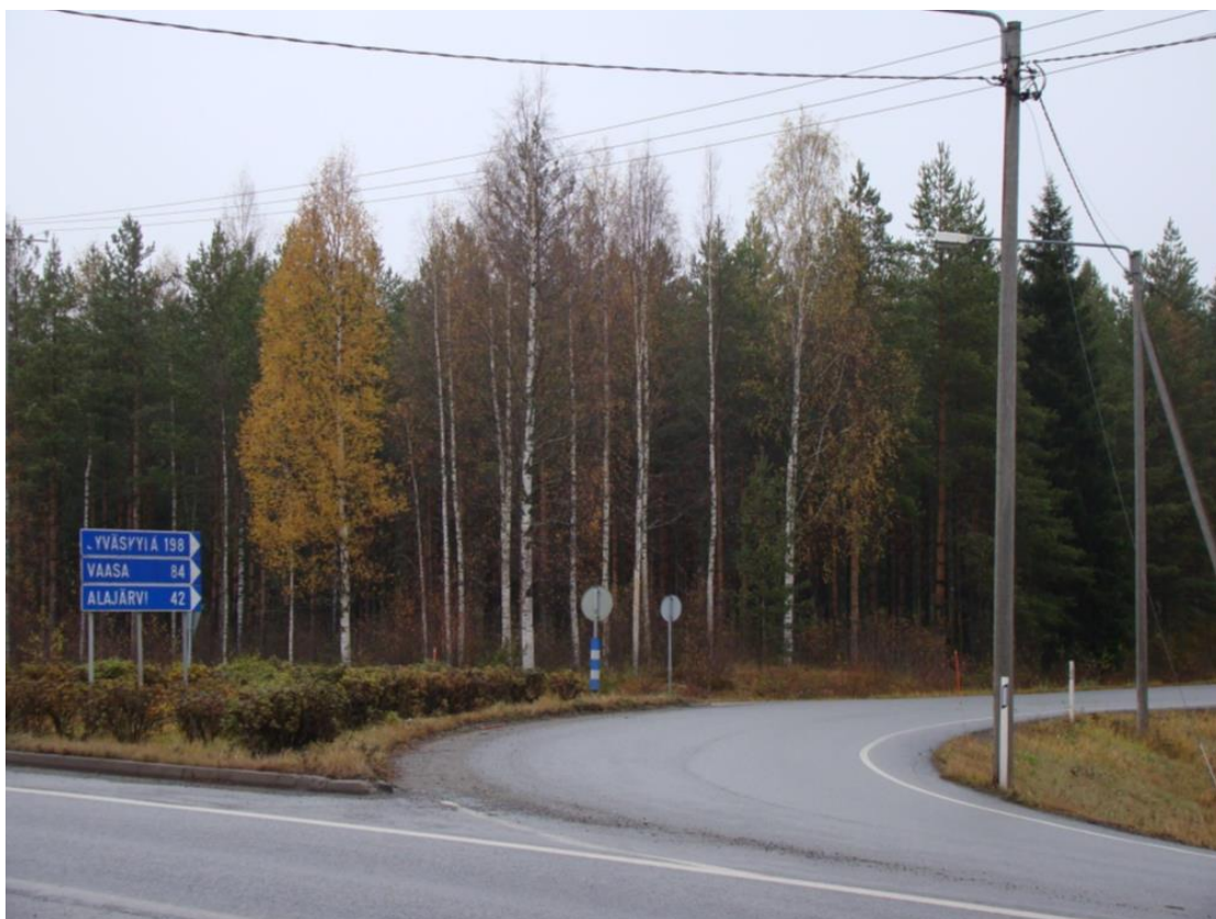
Kuva 15. Valopylväs liian lähellä ajorataa (ELY-keskus s.a.)
