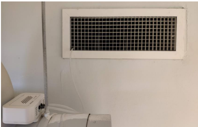
KUVA 18. Mittaukset poistoilmalaitteesta
