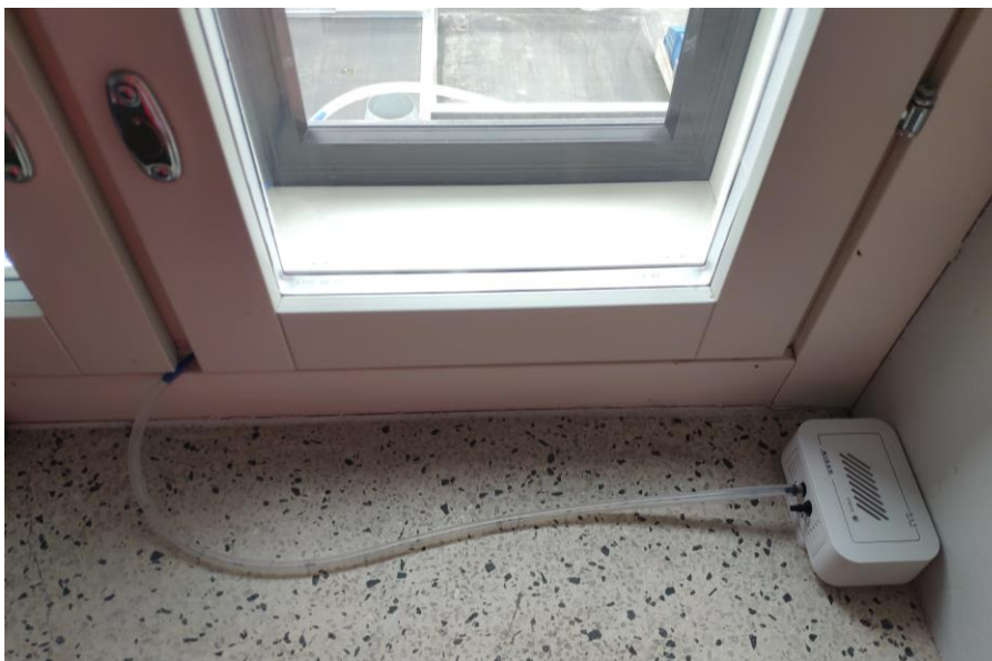
KUVA 15. Paine-eromittaus vaipan yli
