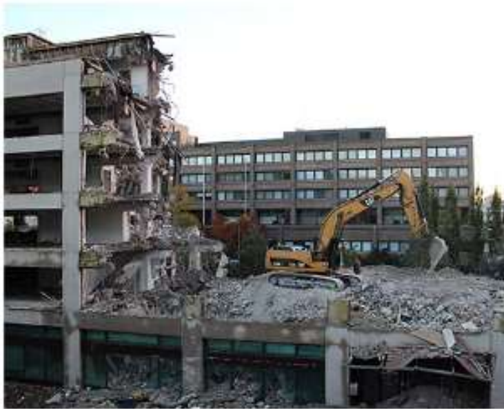
Kuva 5 Purkamisessa syntyy runsaasti betonijätettä [10. s.4]
