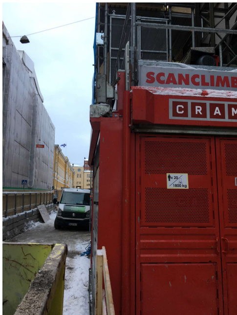
Kuva 13 Rakennushissi U14 [tekijän ottama kuva]
