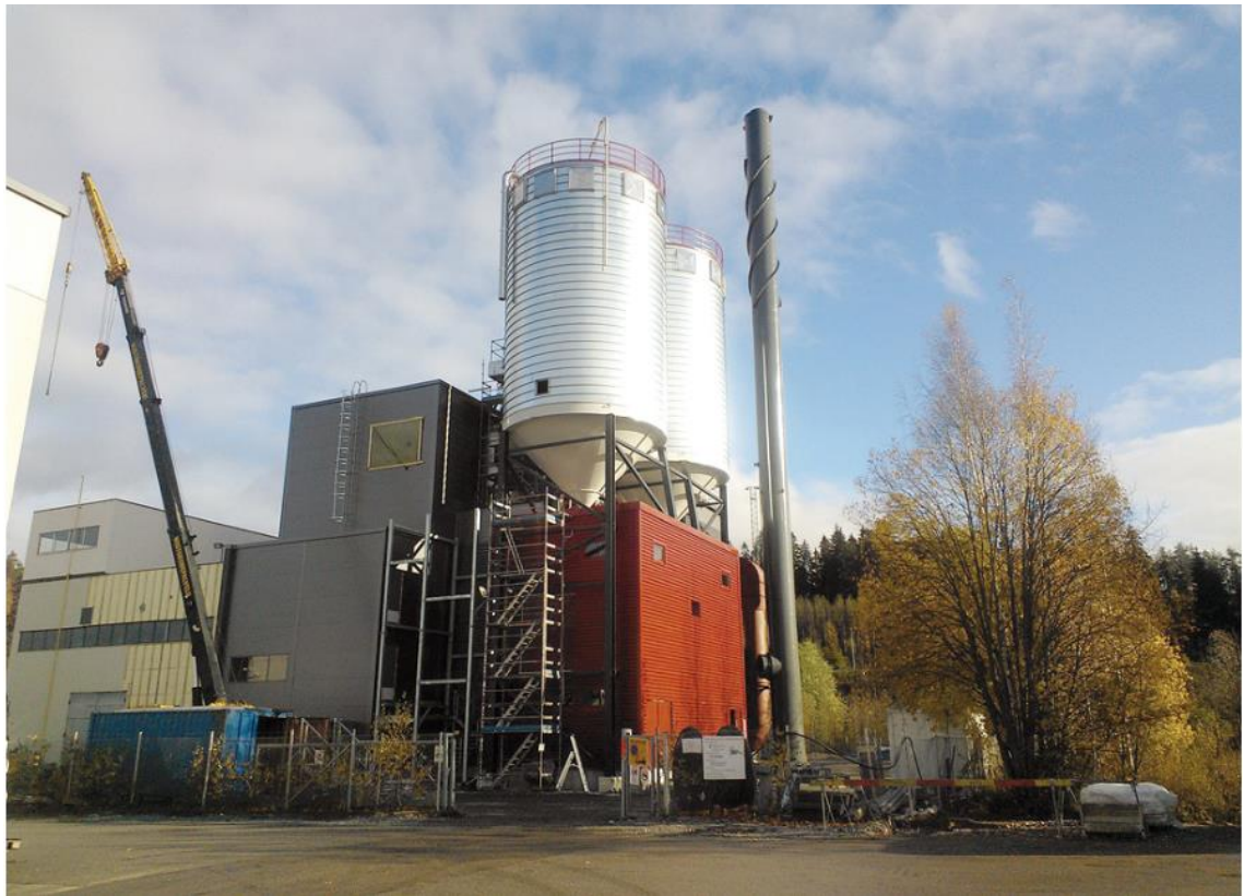
KUVA 10. Sarankulman lämpölaitos (Tampereen Sähkölaitos 2020)
