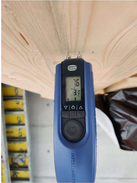
Kuva 10. Kosteuden mittaus CLT-elementistä Gann-kosteusmittarilla.
