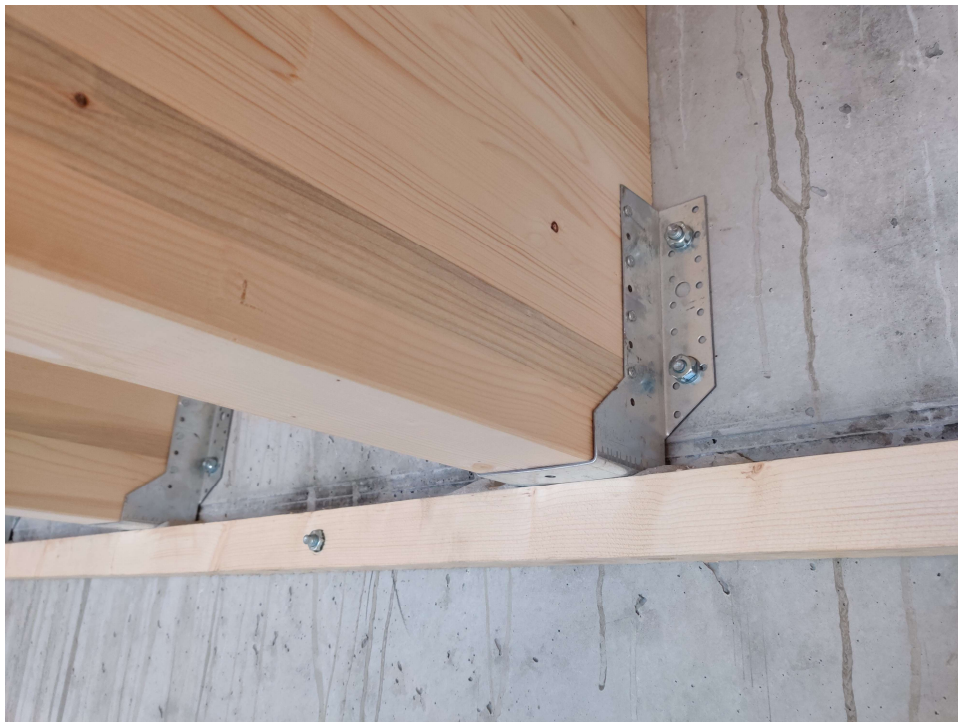
Kuva 27. Välipohjapalkkien kiinnitys jäykistäviin betoniseiniin palkkikengillä.
