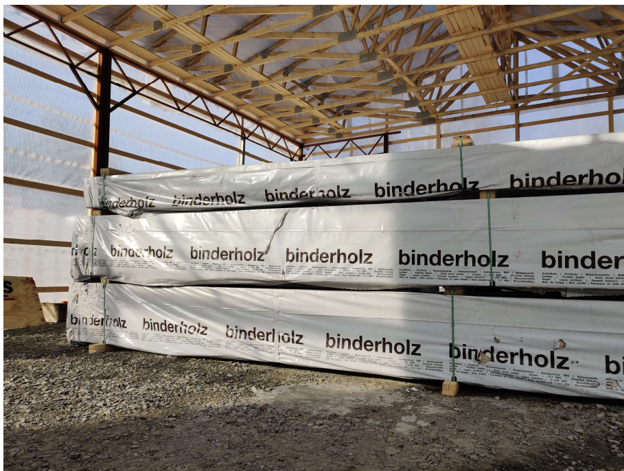
Kuva 12. CLT-elementtien oikeaoppista varastointia hallin sisällä.
