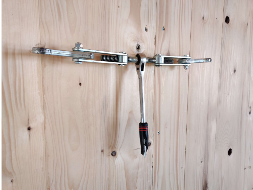
Kuva 22. Elementtivetimellä saadaan saumat tiukasti puskuun.
