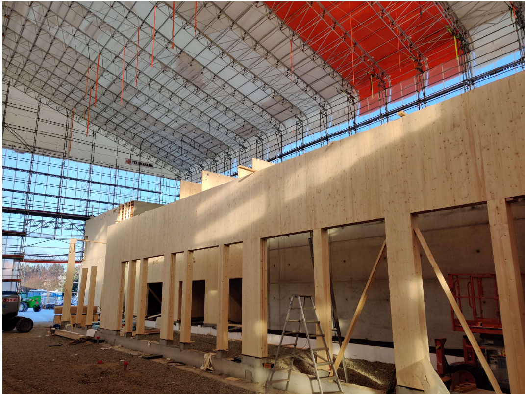
Kuva 24. Opintoaulan CLT-rakenteet.
