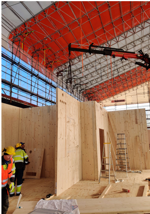
Kuva 29. Toisen kerroksen väliseinäelementtien asennus käynnissä.
