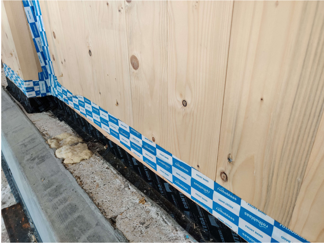
Kuva 20. Ulkoseinäelementin kiinnitys alaohjauspuihin VGZ 7x160mm puuruuveilla.
