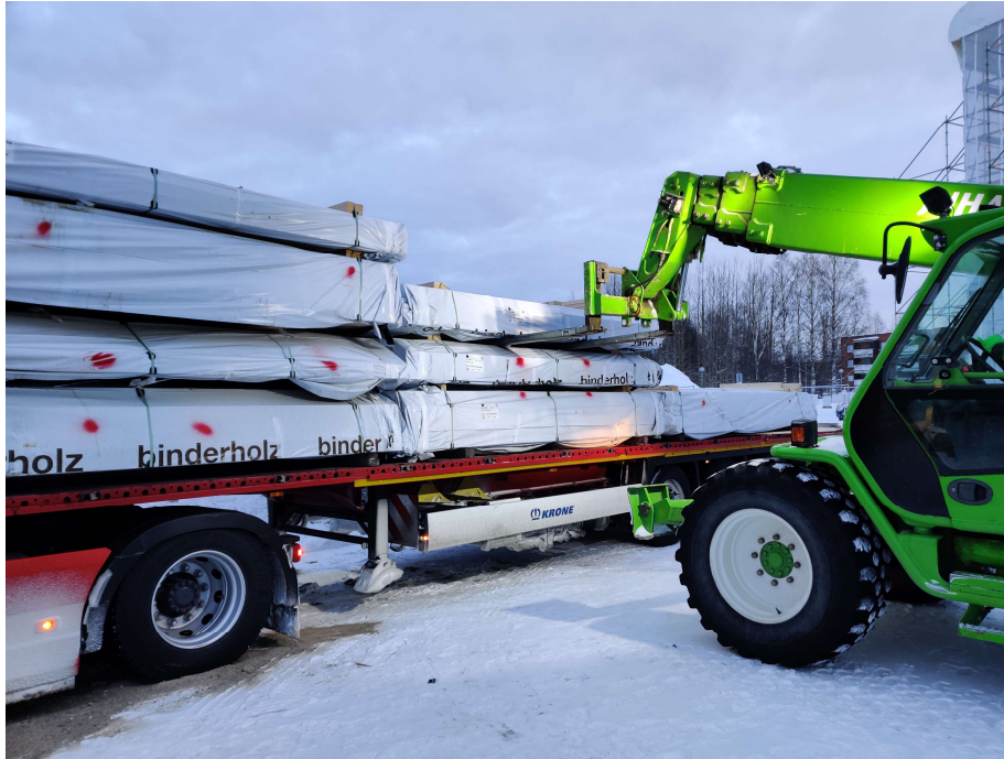
Kuva 14. Suojamuoveihin pakattujen elementtien purkua kuormasta kurottajalla.
