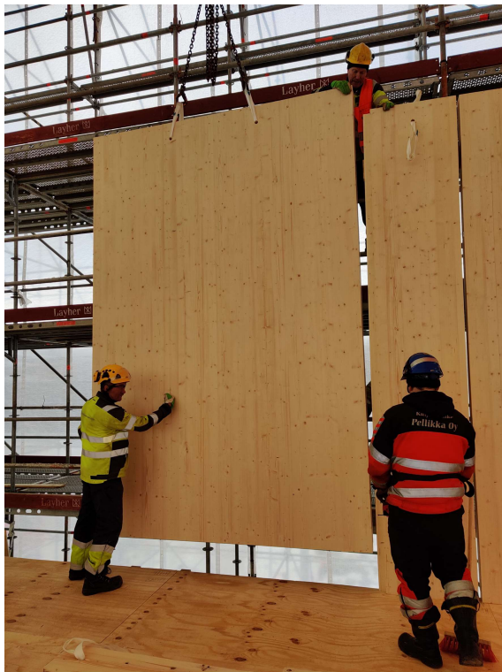
Kuva 28. Ulkoseinäelementtien asennus käynnissä toisessa kerroksessa.
