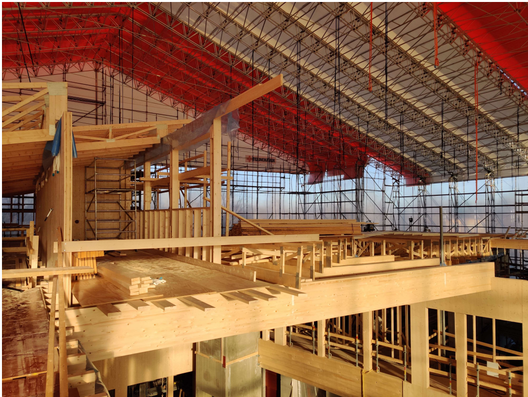
Kuva 31. Aulan yläpuoliset rakenteet.
