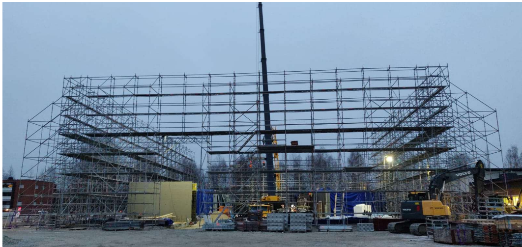
Kuva 7. Tadano 220t autonosturi sääsuojan kattotuolien nostovalmiudessa.
