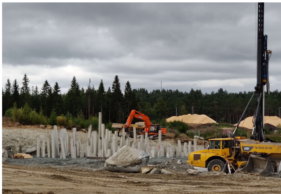
Kuva 2. Paalutus- ja maansiirtotyöt käynnissä Vapon aktiivihiihtehtaalalla.
