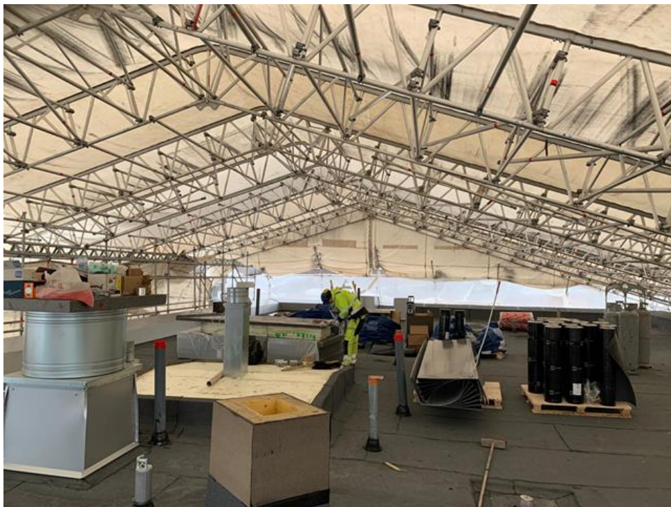
Kuva 3. Vesikaton rakentamista sääsuojan alla.
