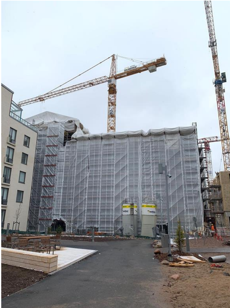
Kuva 1. Kauttaaltaan huputettu rakennuskohde.
