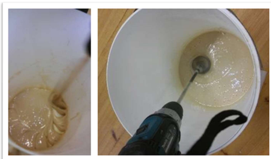
Kuva 29 Liiman sekoitus itse tehdyllä puulastalla vasemmalla sekä oikealla liiman sekoitus sekoitusvispilällä. Molemmat toimivat yhtä hyvin, mutta tarkoitukseen valmistetun vispilän kiinnittäminen oli helpompaa ja se pysyi paremmin kiinni porakoneen istukassa. (Köckritz 2018.)
