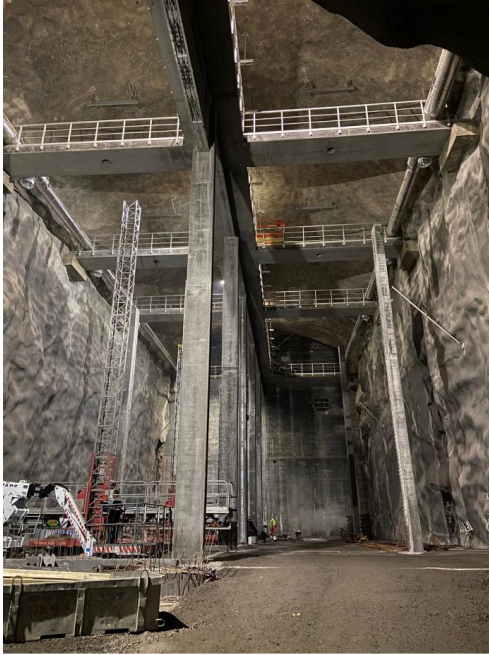
Kuva 10. Ilmastusaltaan pilarit ja hoitotasot. Harkkototeutuksen alkutila.
