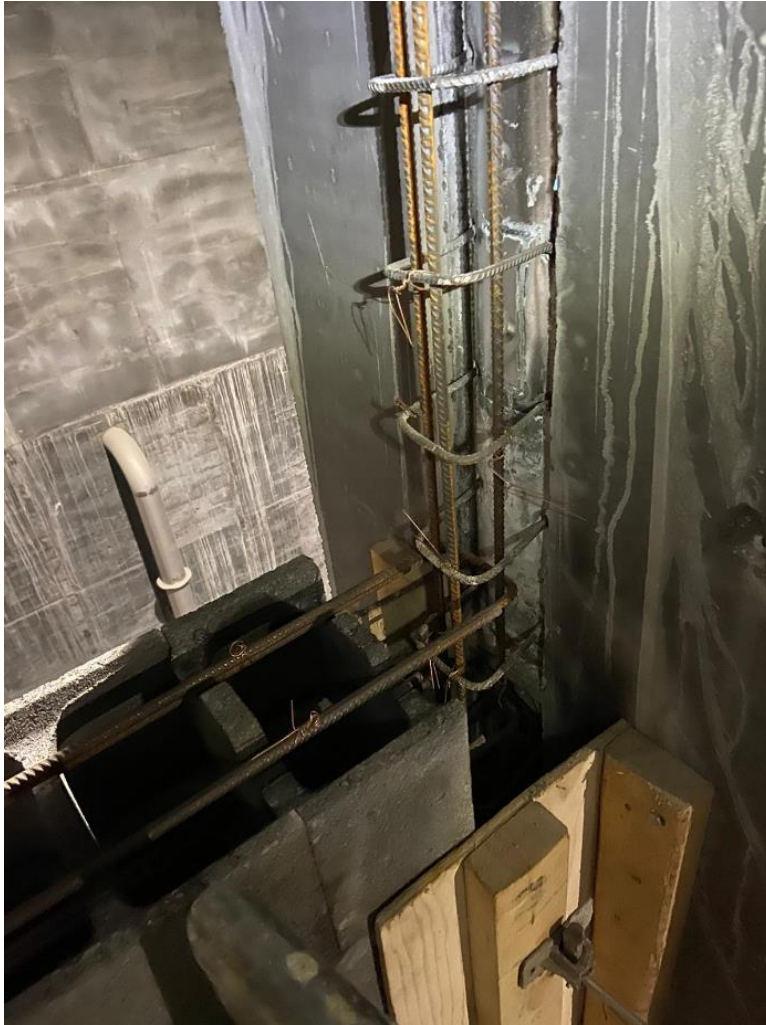
Kuva 16. Raudoituksen kiinnitys pilarin tartuntarautoihin.
