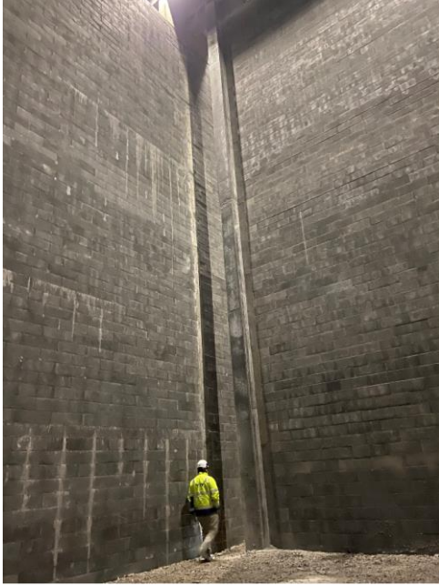
Kuva 5. Hapettomasta tilasta vesi siirtyy seuraavaan osioon kapeasta raosta.
