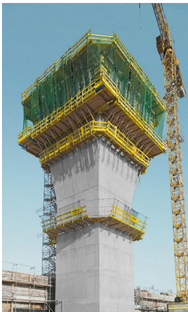
Kuva 19. Kiipeävä muottijärjestelmä
