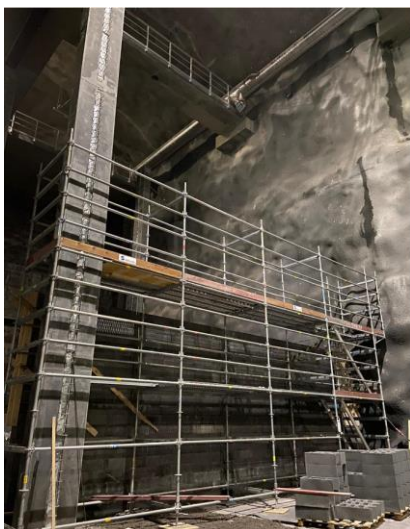
Kuva 18. Ilmastusaltaan väliseinä työssä käytetyt telineet.
