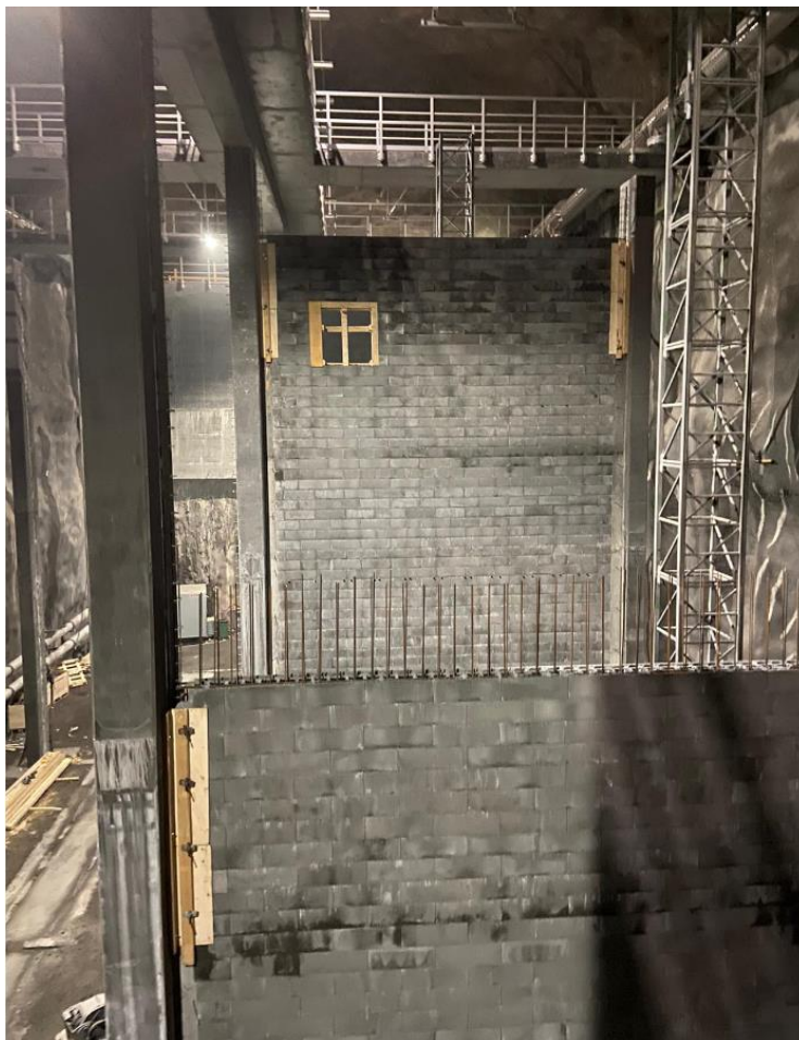
Kuva 15. Harkkoseinän pystyraudoitus
