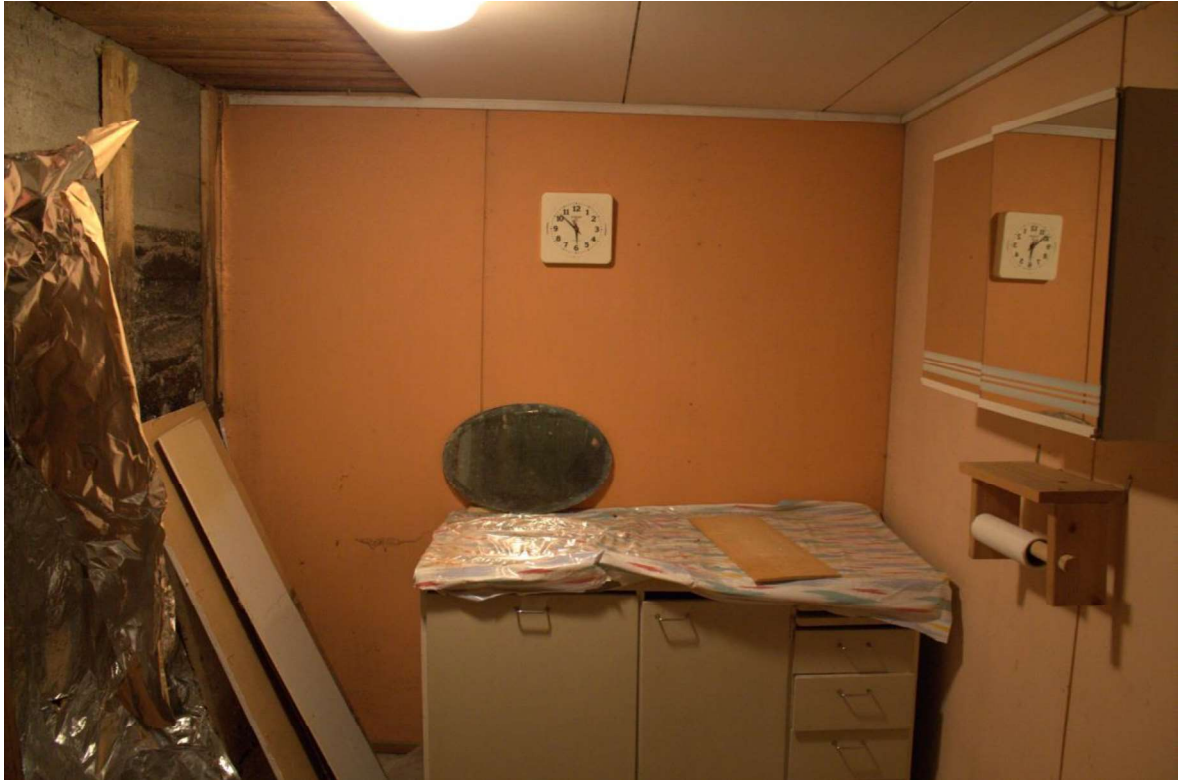
Kuva 2. Kellarin vanha pukuhuone. (Latva-Ranto H. 2019)
