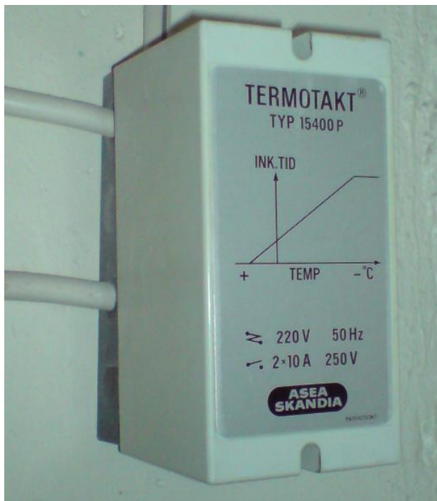
KUVA 1. Tekman paikoitusalueen sähkönsyöttöä ohjaava ASEA SKANDIA Termotakt. Kuva Marko Kauranen, 2010.
