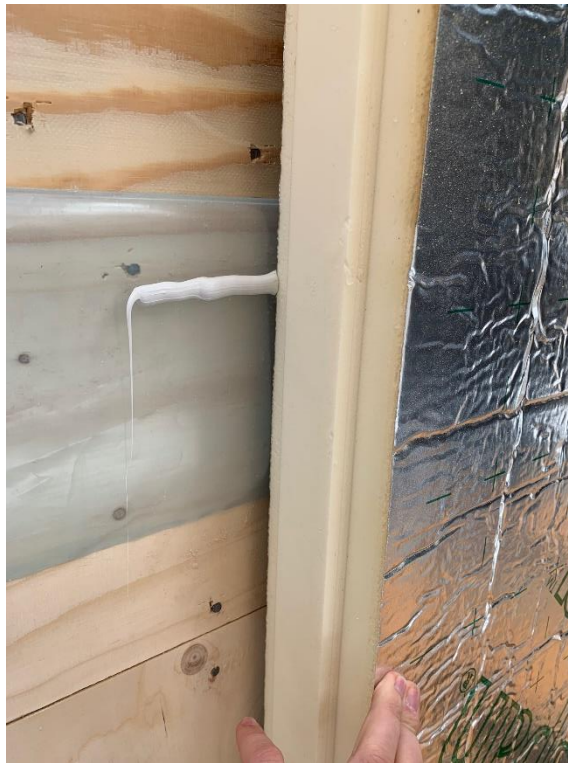
Kuva 4. Höyrynsulkumuovin ja seinän eristelevyn liitos.
