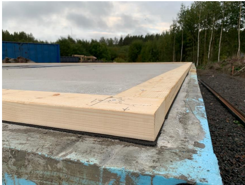
Kuva 5. Alaohjauspuun eristäminen bitumikaistaleella.
