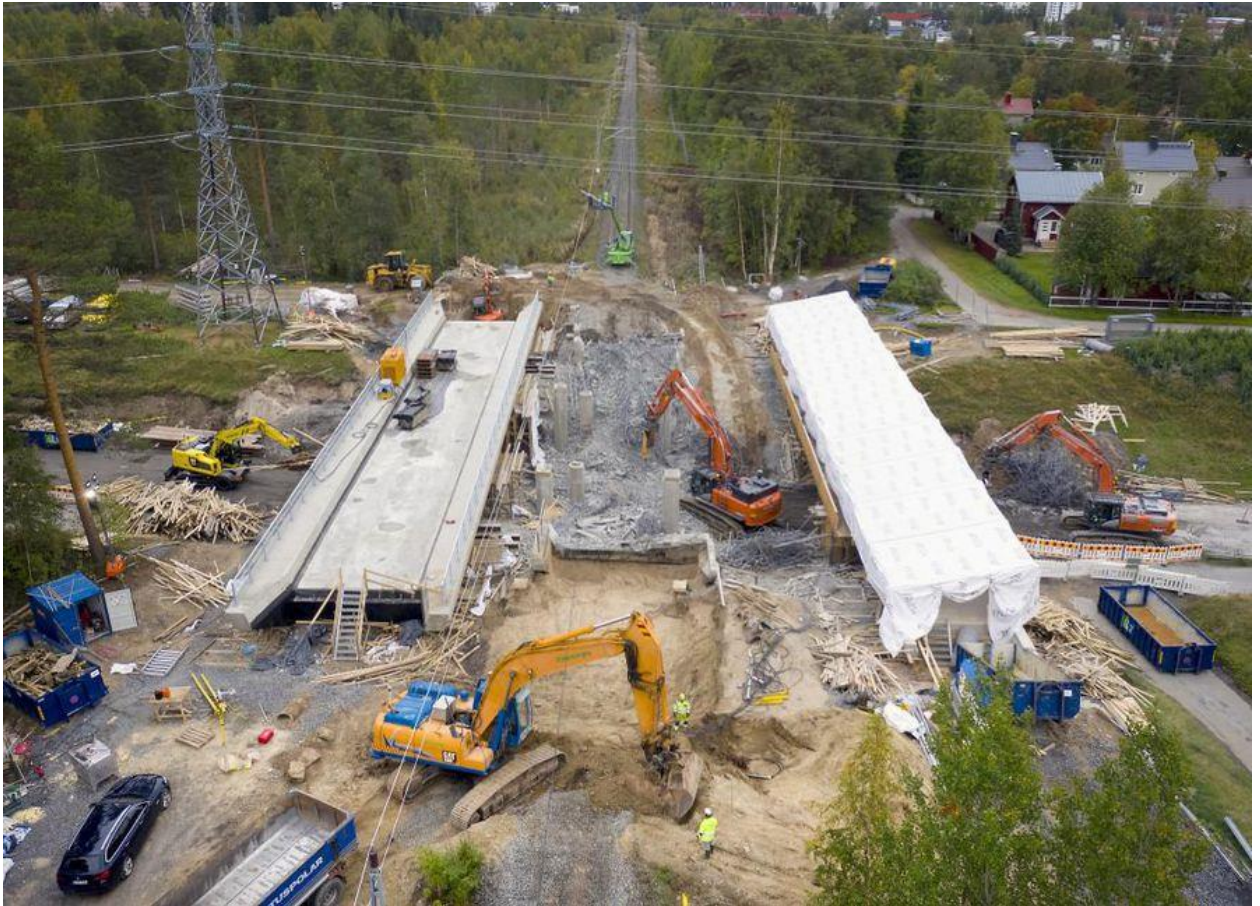
KUVA 10. Tilanne sillan purkamisen jälkeen (10)
