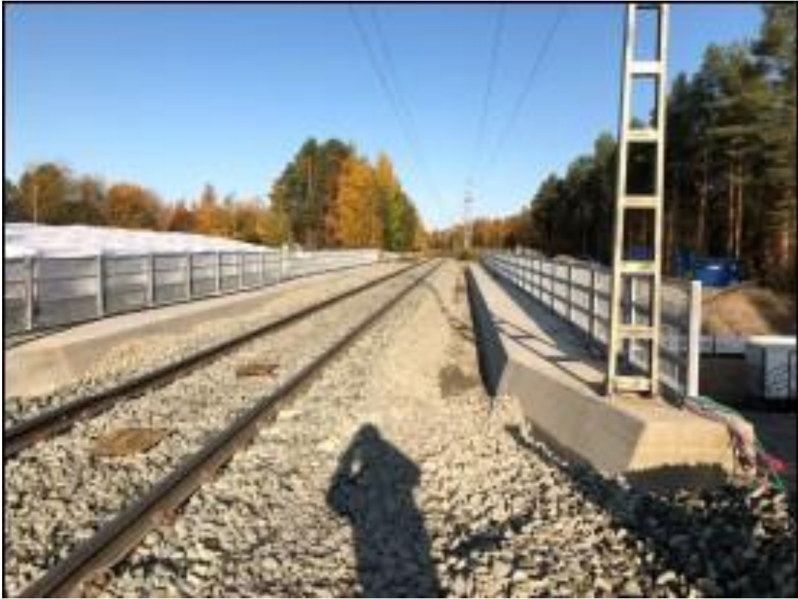
KUVA 11. Liikenteelle luovutettu silta siirotkatkon jälkeen
