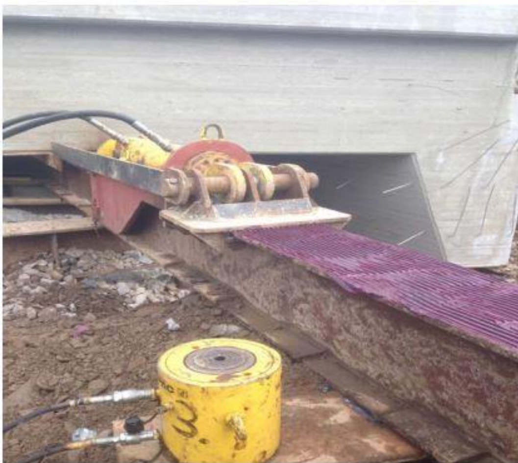
KUVA 7. Sillan siirtoon käytetyt siirto- ja nostotunkit (8, s. 27)
