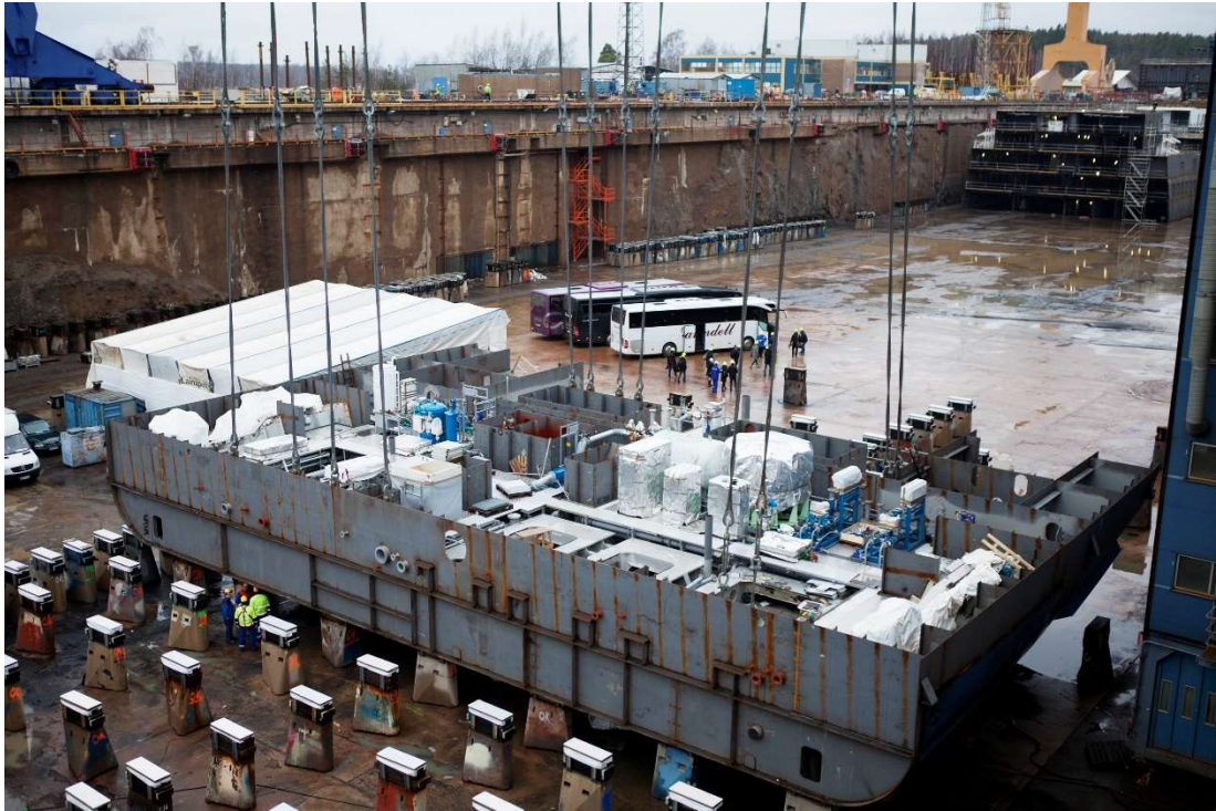
Kuva 3. Tallink Megastar -aluksen lohko rakennusaltaassa (Meyer Turku 2019).
