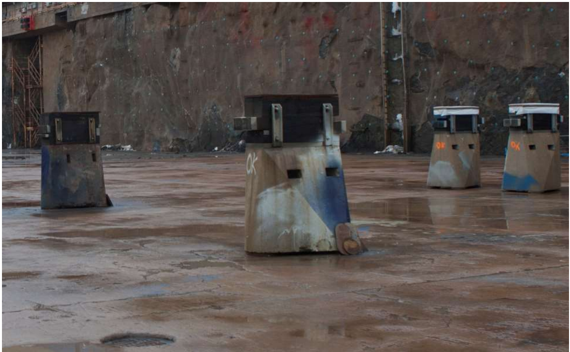
Kuva 7. Pukit, joiden päälle laiva rakennetaan.
