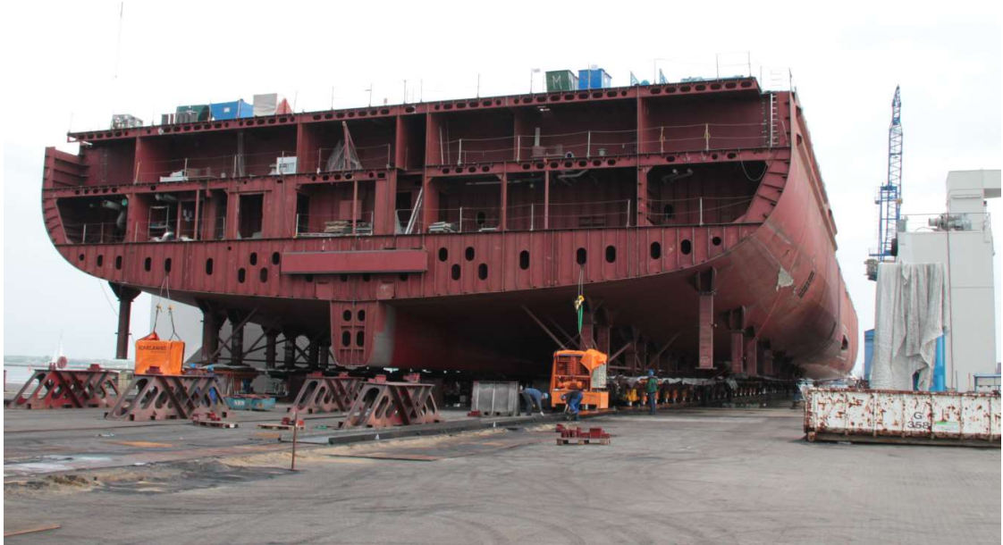
Kuva 10. NB-1394:n FERU siirtolaitteiston päällä (Meyer Turku).
