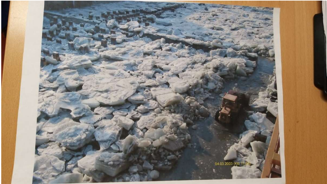
Kuva 22. Altaan pohjan siivousta keväällä 2003.
