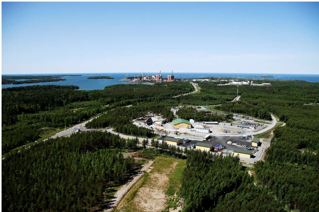
Kuva 2. Ilmakuva Posivan työmaa-alueesta Olkiluodossa kesällä 2009. (Posivan www-sivut 2019 B.)
