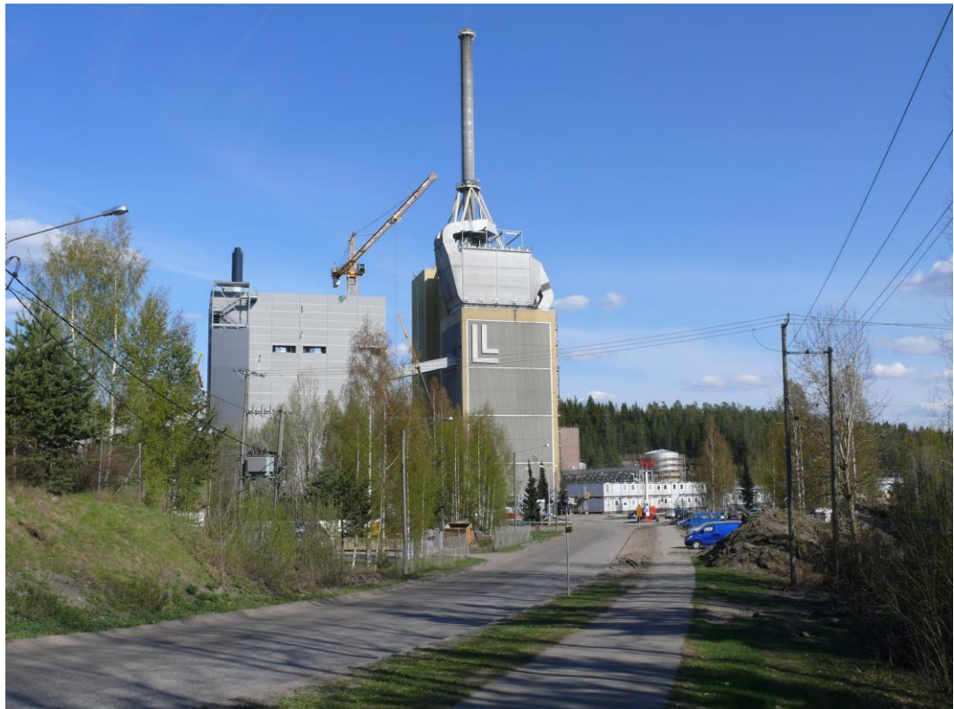
KUVIO 1. Rakenteilla oleva KYVO2 kaasutusvoimalaitos vasemmalla ja Kymijärven voimalaitos oikealla
