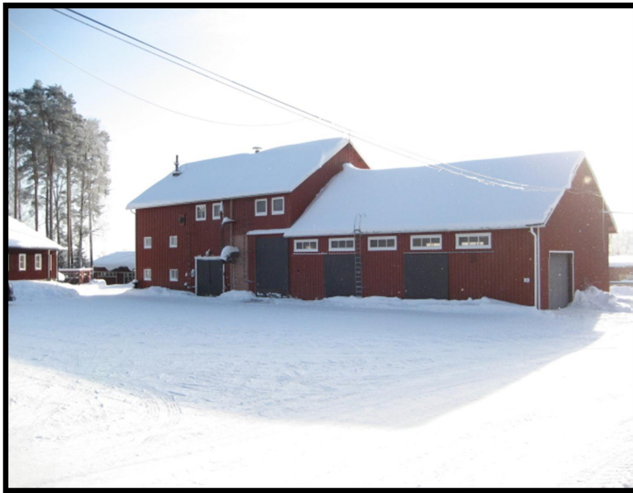
KUVIO 4 Kuivurirakennus parkkipaikalta päin kuvattuna.
