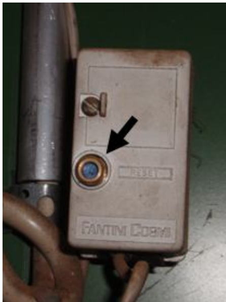
KUVIO 36. Kattilan ylikuumenemissuoja
