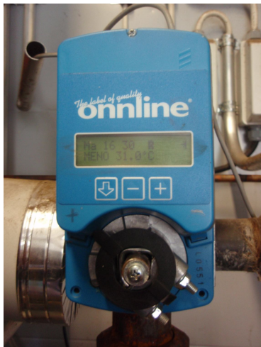
KUVIO 25. Linjasäätöventtiili eli "suntti" lämmönjakuhuoneessa
