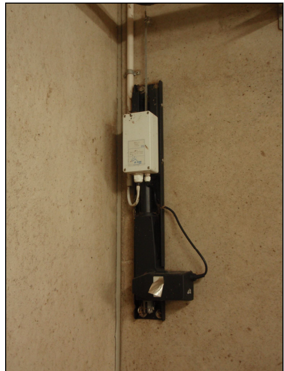
KUVIO 15. Luukkujen säätömoottori
