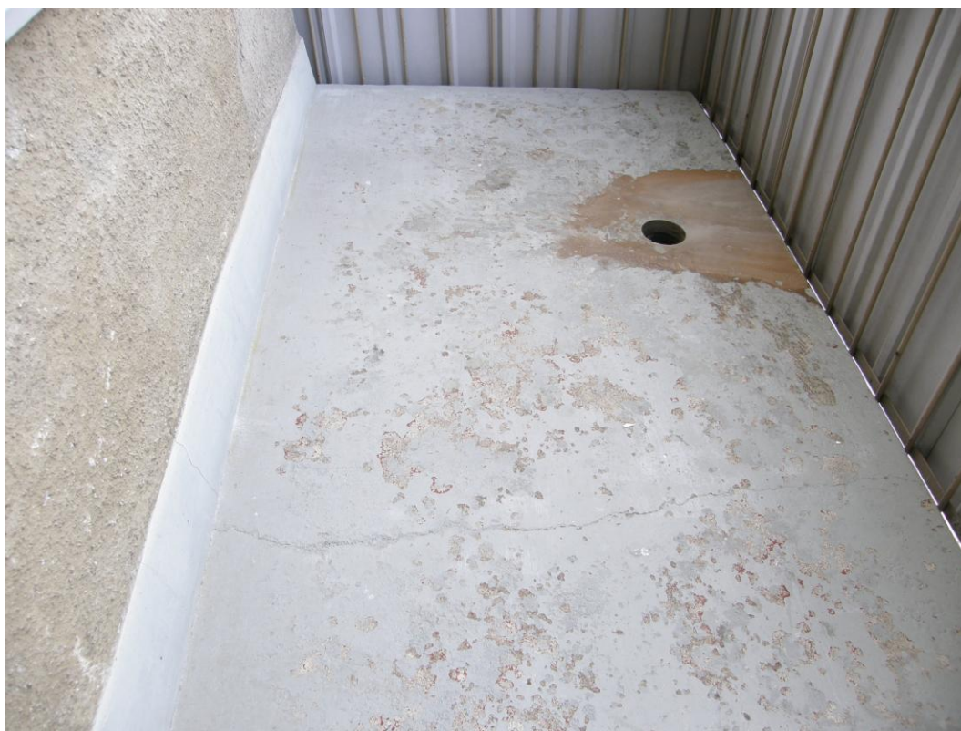
Kuva 7. Parvekelaatan yläpintaa ja juuri poratun näytteen kolo.
