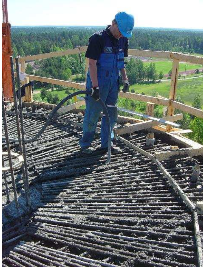
Kuva 6 Paksun holvilaatan jälkitiivistäminen (12.)
