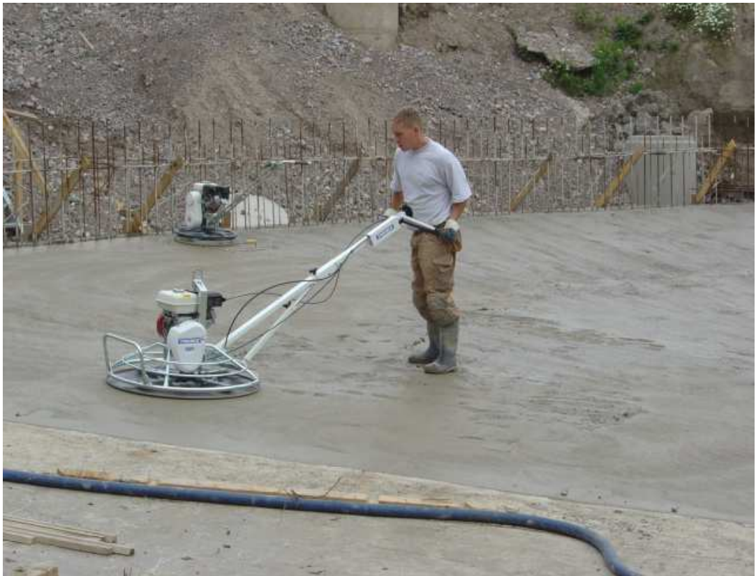
Kuva 10 Koneellinen hierto betonipinnalle (12.)
