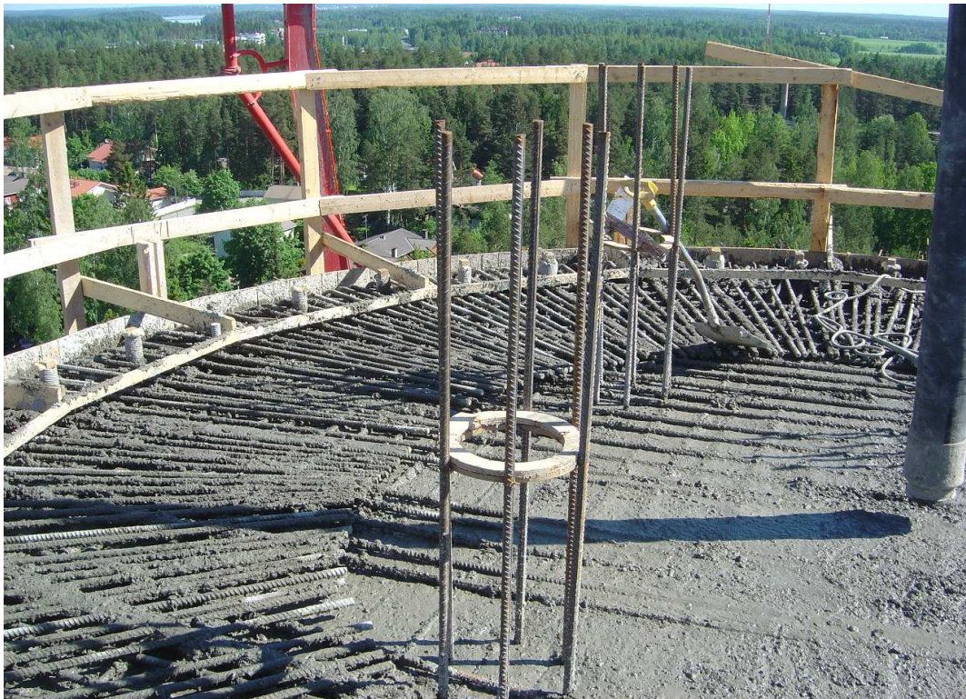
Kuva 9 Paksun holvilaatan betonointi (12.)
