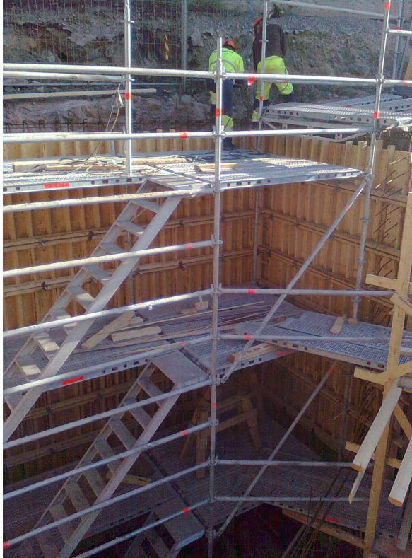
Kuva 8 Valuputken vaativa seinävalu (14.)
