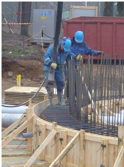
Kuva 4 Vesitiiviin rakenteen betonointi (12.)
