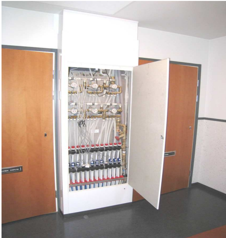
KUVA 4. Jakotukkikaappi porrashuoneessa
