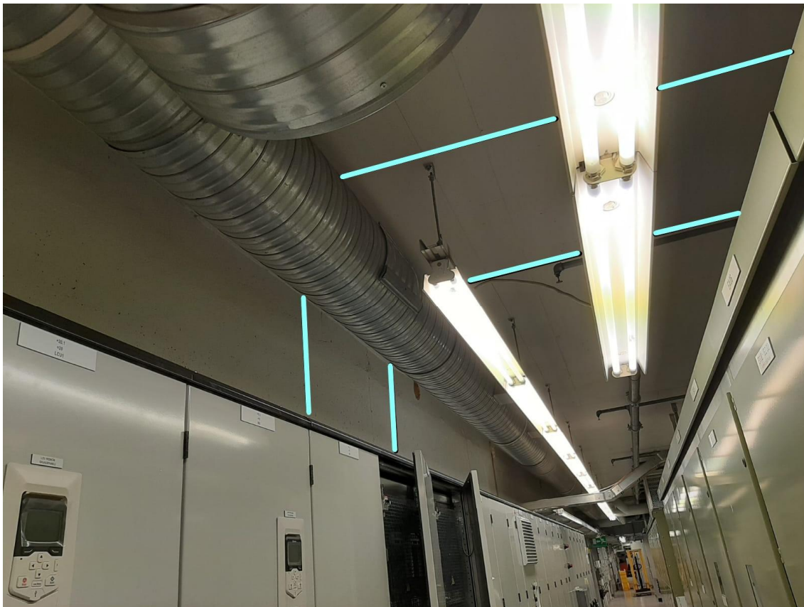
Kuva 28. Kaapeleiden nousu lähtöyksiköltä.
